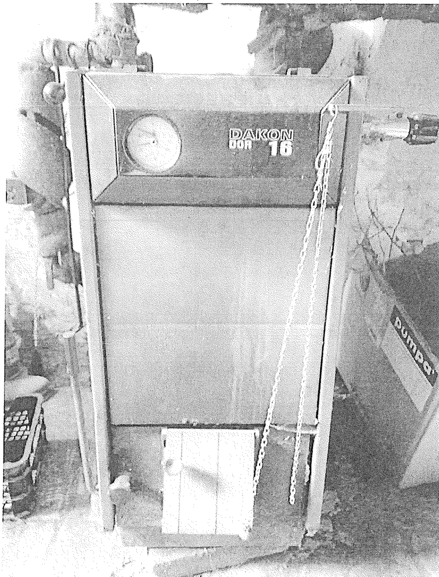
Fotodokumentace stávajícího kotle na tuhá paliva – Břečka Martin, Lovčovice č.p. 3, 675 31
