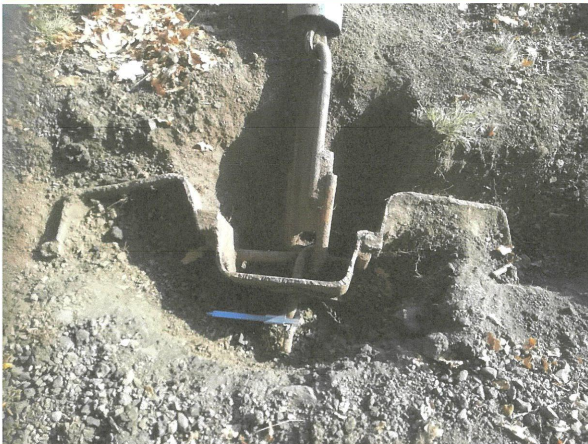
Obrázek 4: Skutečný stav štetovnicových kotevních prvků
