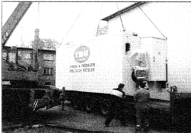
nakládka kotelný dlouhými lany
