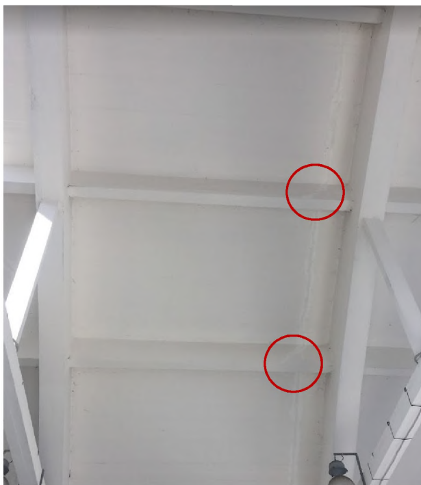
Obrázek 5 – Průběžná trhlina procházející i žebry
