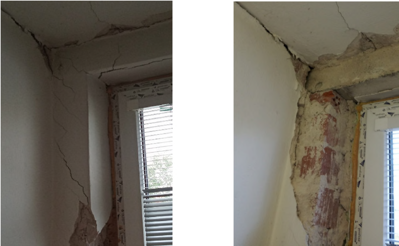
Obrázek 12 – Místo Q1.1, stav před a po odstranění omítky
