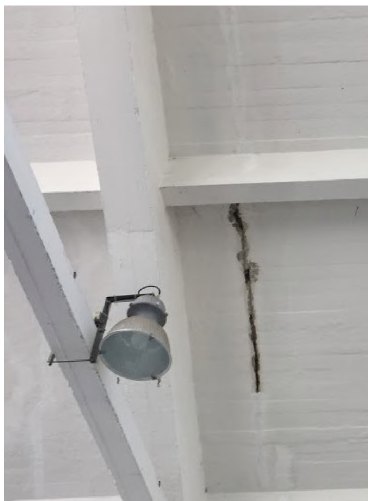
Obrázek 12 – Odstraněná zdegradovaná část
