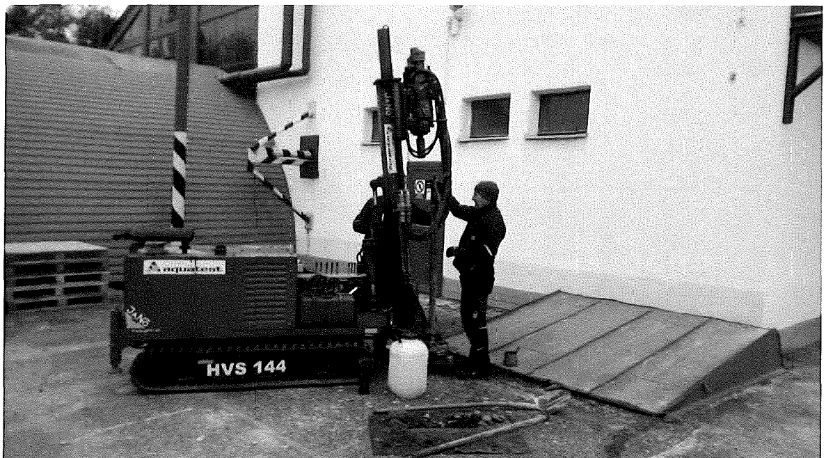
Foto č. 4: Vrtné práce (26.11. 2019)
