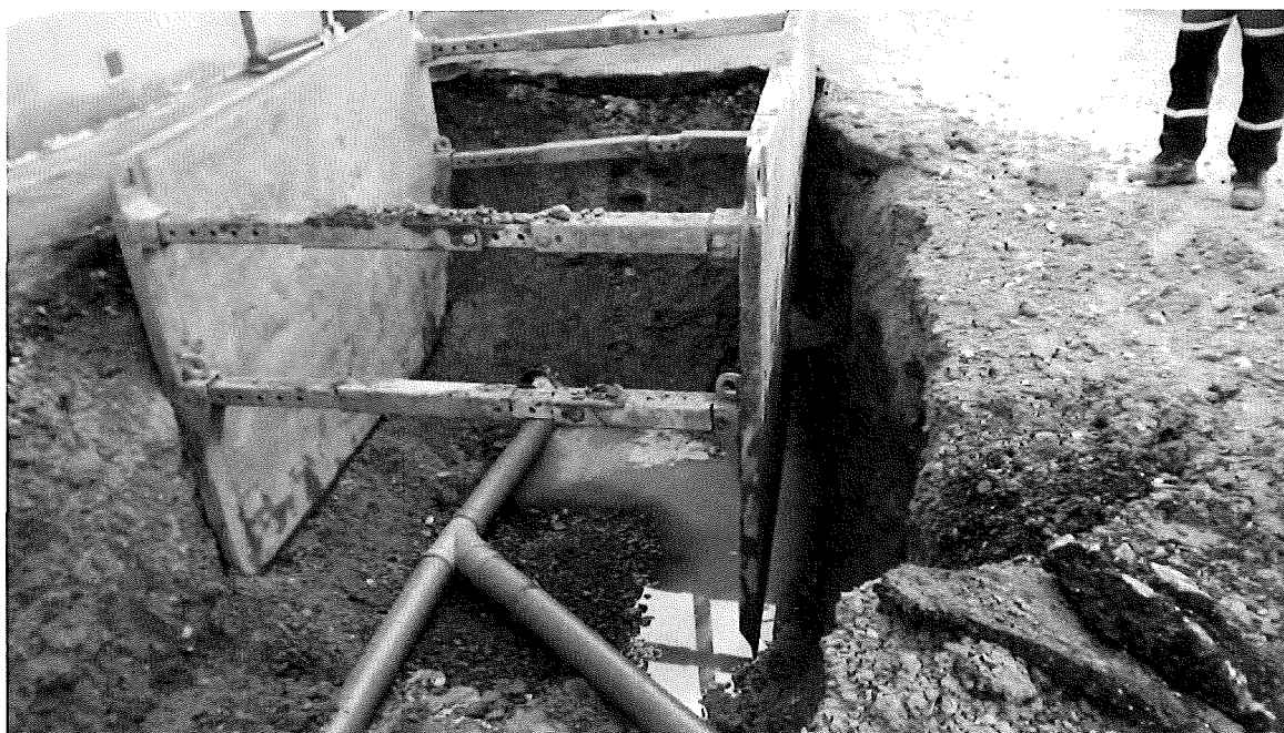
Foto č. 2: Výkop SV1 (16.10. 2019)
