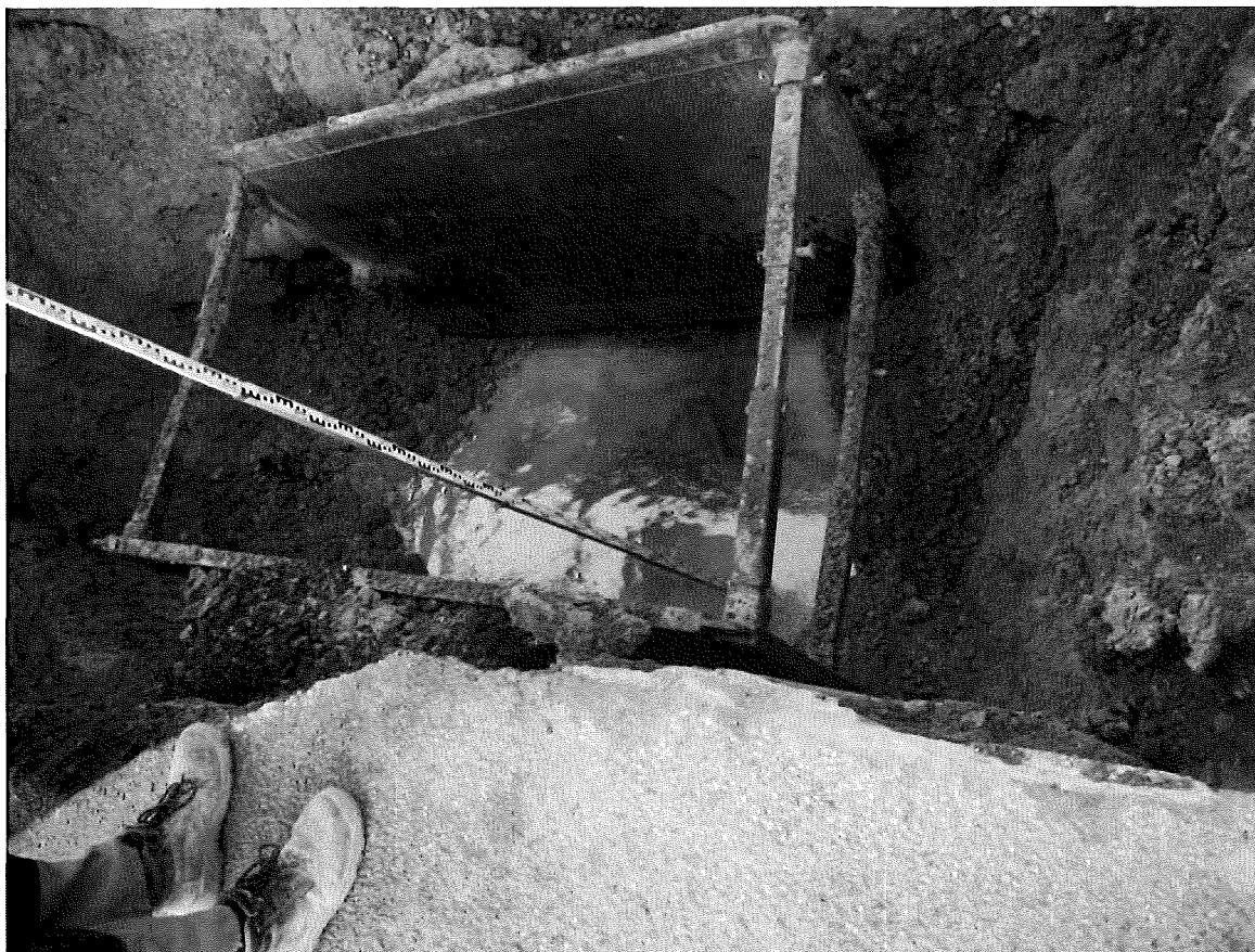
Foto č. 1: Výkop SV1 (14.10.2019)
