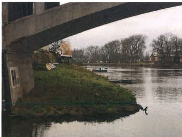
Obr. 1: Prostor u mostní opěry – použití přenosné soupravy
