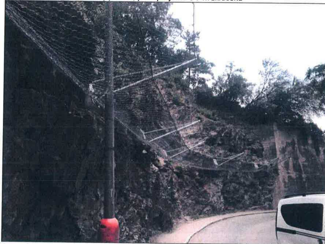
Kotvení skalního bloku dvěma kotvami u lampy pouličního osvětlení
