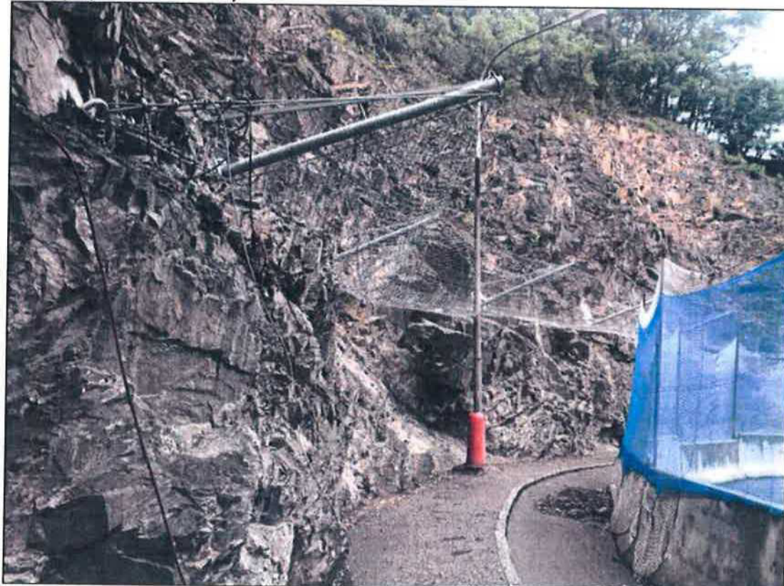
Instalace sítě a lan dynamické bariéry
