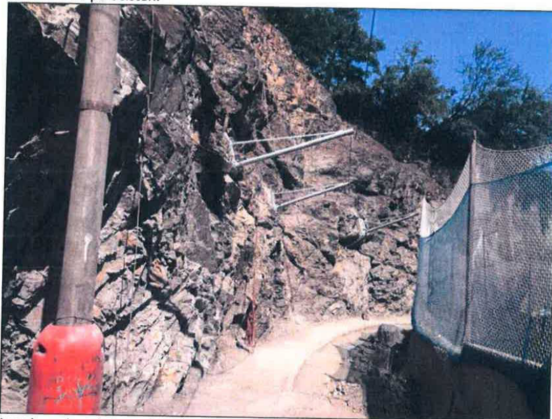
Instalace sloupů dynamické bariéry
