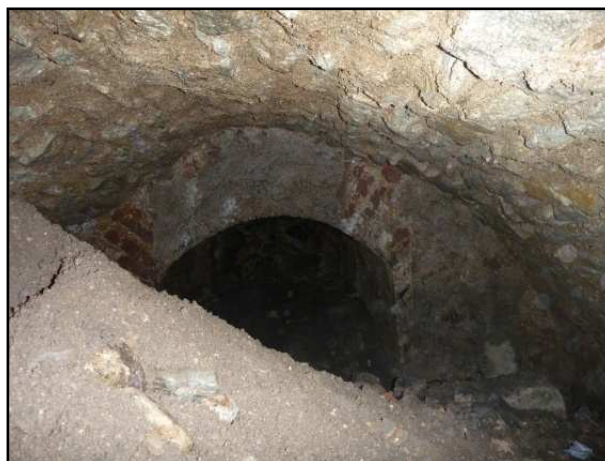
Foto 0239. Pohled od uvolněné šachtičky k cihelné části na severozápadě
