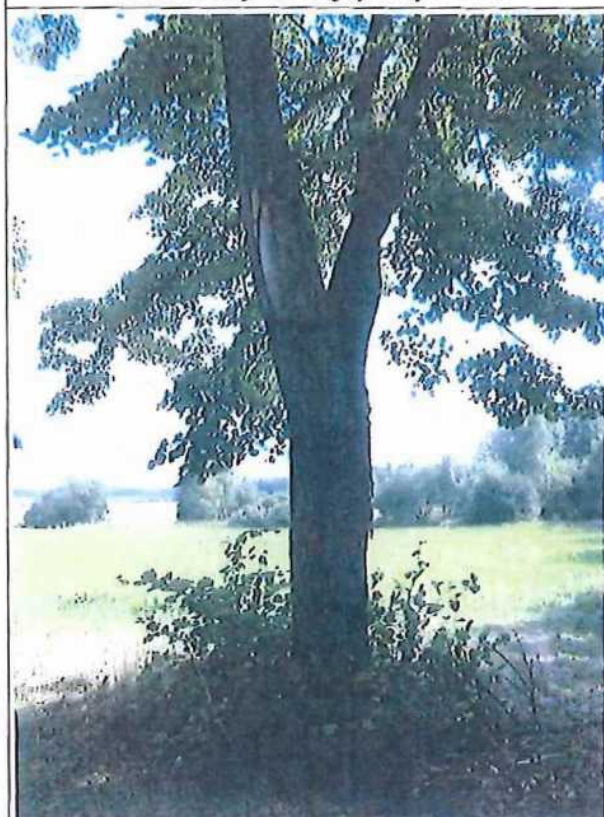
Typické poškození kmene (zde lípa číslo 50) a narůstající výmladky, které budou v rámci řezu odstraněny.
