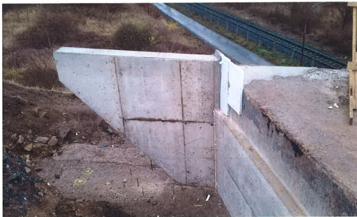
Foto č. 12 – Pohled na rub pravého křídla opěry 4 (VP č. 7)
