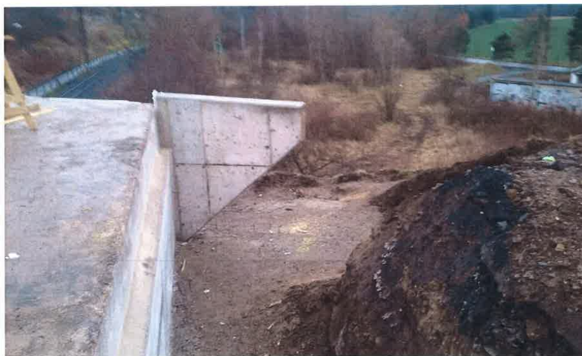
Foto č. 10 – Pohled na rub pravého křídla opěry 1 (VP č. 7)
