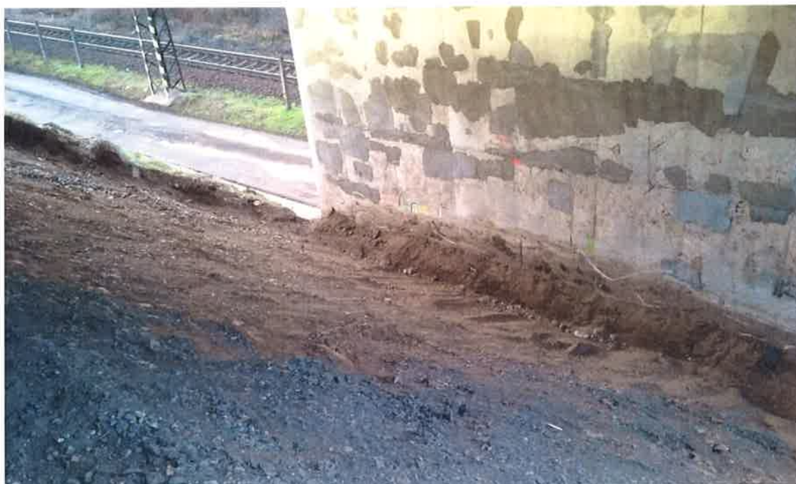
Foto č. 4 – Pohled na srovnaný svah před opěrou 1 (VP č. 4)
