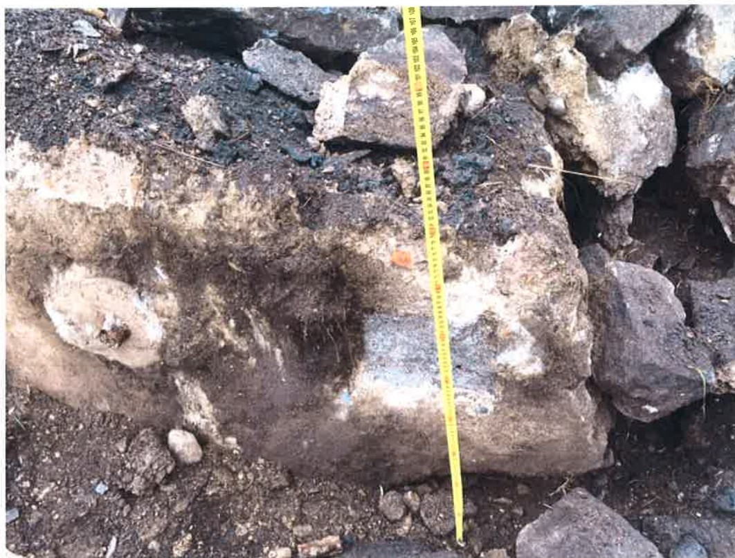
Foto č. 6 – Detail vybouraných betonových bloků u opěry 1 (VP č. 5)
