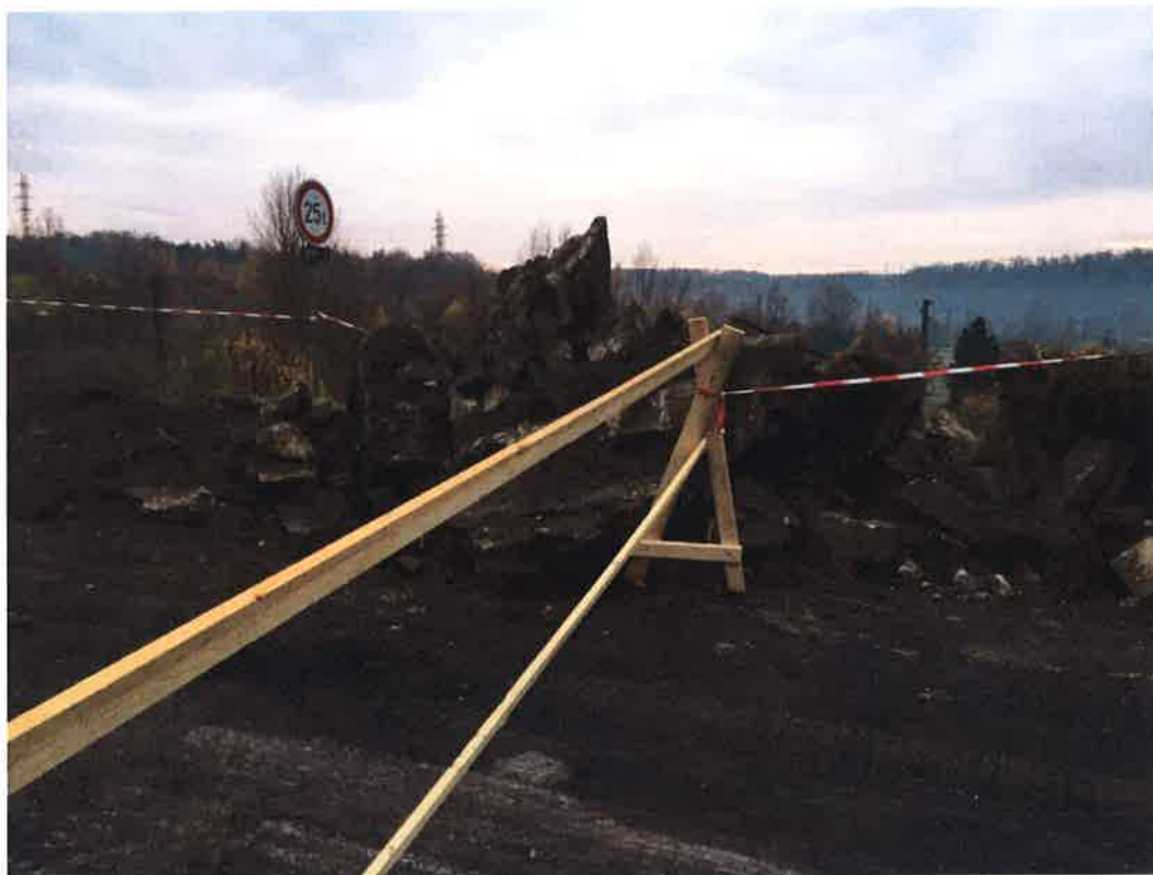
Foto č. 5 – Vybourané betonové bloky u opěry 1 (VP č. 5)
