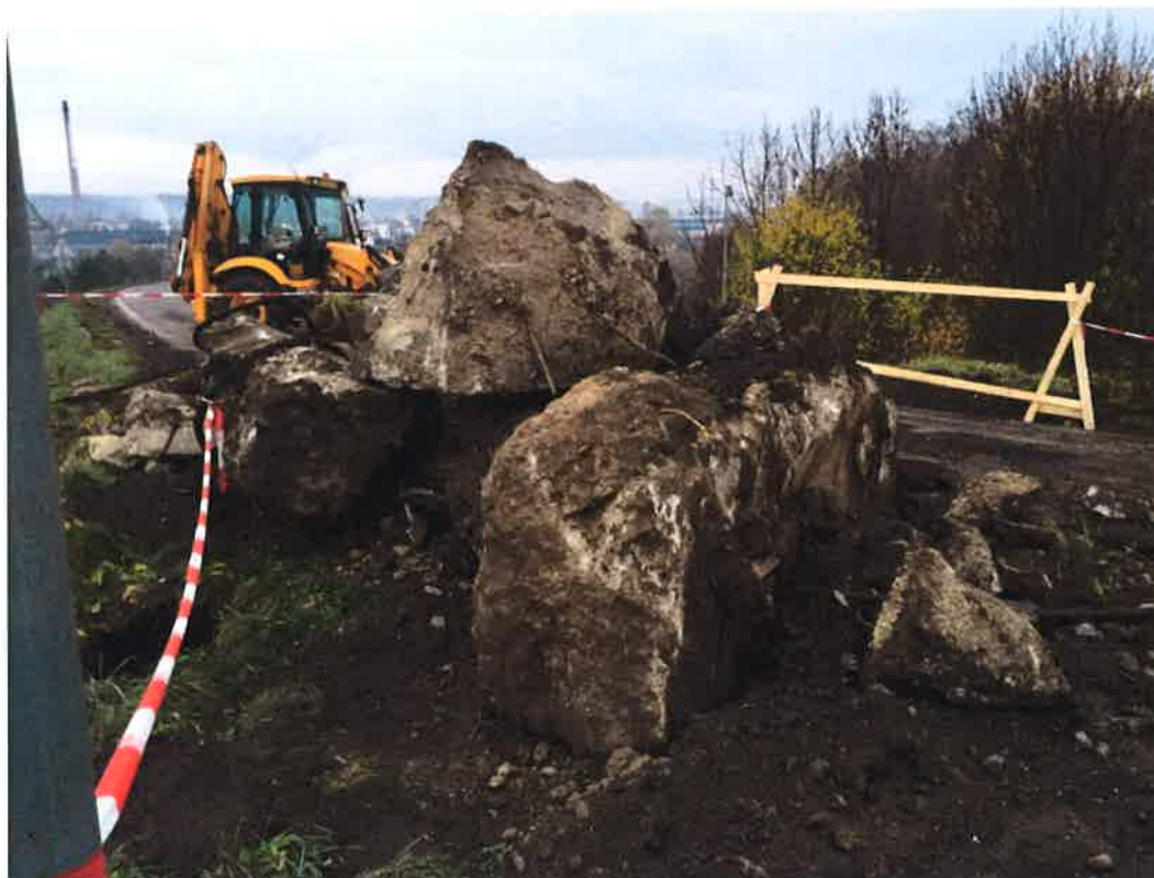
Foto č. 7 – Vybourané betonové bloky u opěry 4 (VP č. 5)
