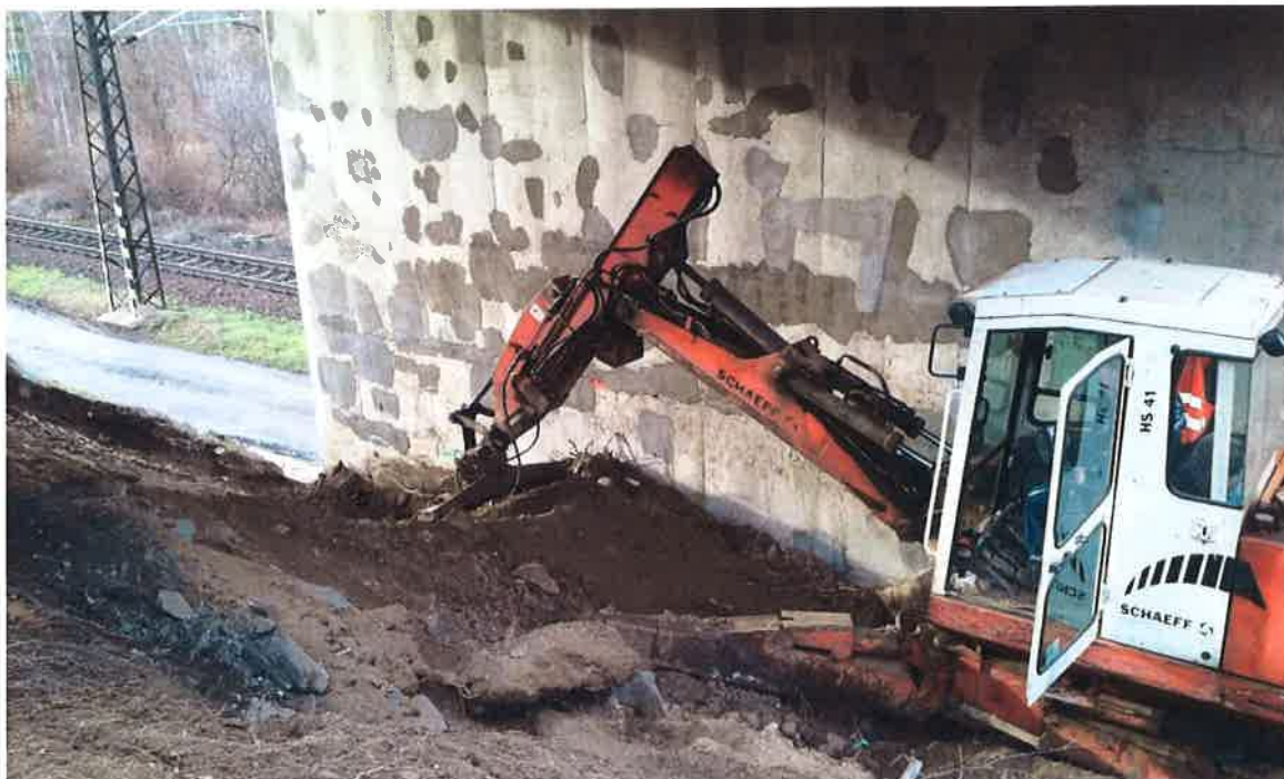
Foto č. 3 – Odtěžování „vyteklé“ zeminy z prostoru před opěrou 1 (VP č. 4)
