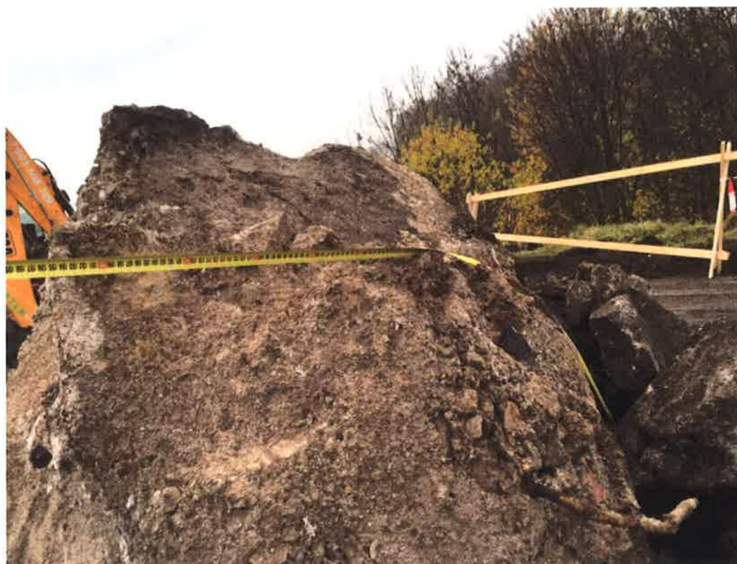
Foto č. 8 - Detail vybouraných betonových bloků u opěry 4 (VP č. 5)
