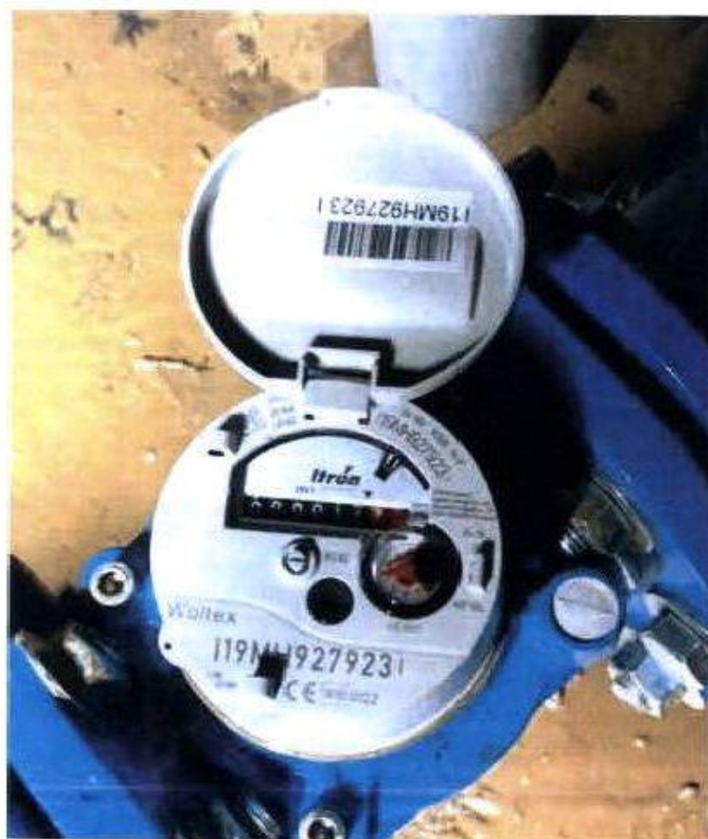
Příloha č. 2: Fotografie instalovaného měřidla se značkou ověření měřidla
