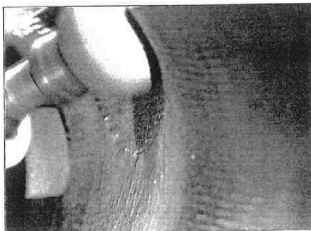
- prořezání stávajících zaústěných přípojek robotem
