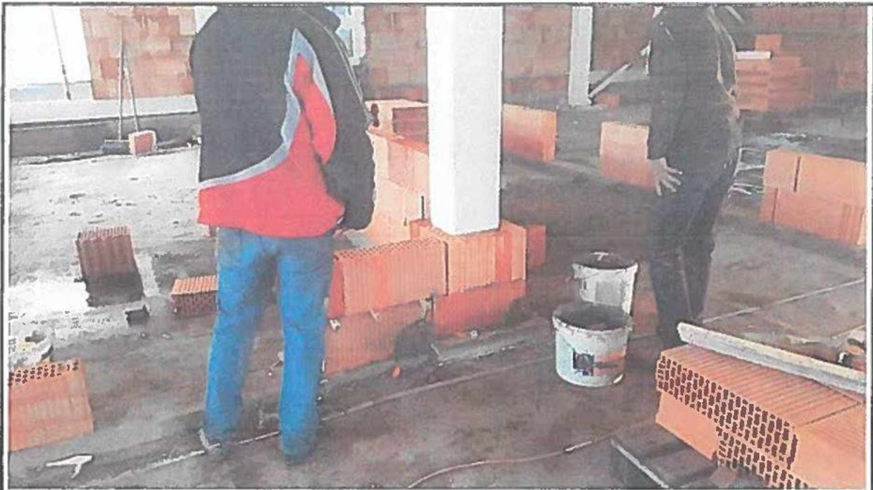
Obezdvka ocelových sloupů cihelnou tvárnici.
