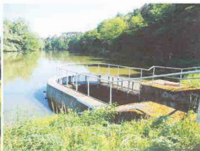
jižní pohled, bezpečnostní přeliv
