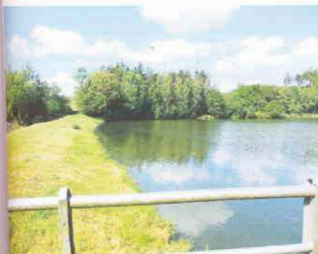
celkový pohled na hráz nádrže
