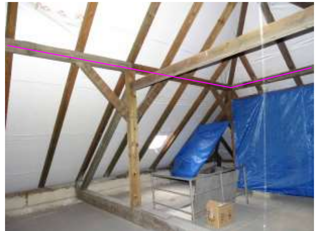
EST.1 – trasa přívodu OS sirény napájení - půda
