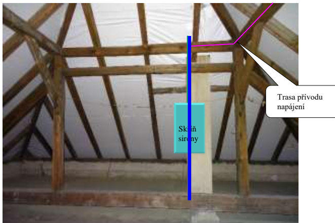
EST.1 – půdní prostor MŠ – umístění stožáru a ovládací skříň
