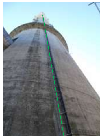
Obr. P2-6 – kabel k anténě ve stávající trase MP (LCFS114-50 JA-A, na příchytky)
