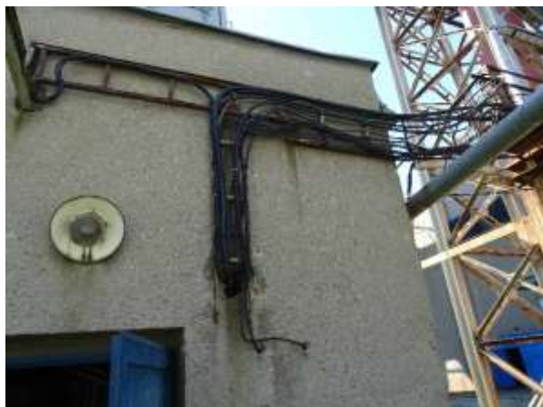
Obr. P2-11 – stávající průraz z budovy výměníku ke konstrukce závěsu 1 pro nový přívod napájení převaděče (kabel CYKY-J 3x2,5)
