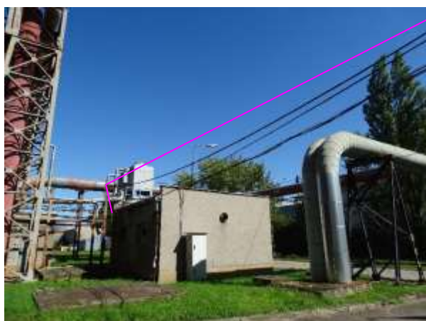
Obr. P2-9 – nový závěs 1 k budově výměníku, napnutí bude min 50cm nad stávajícími závěsy
