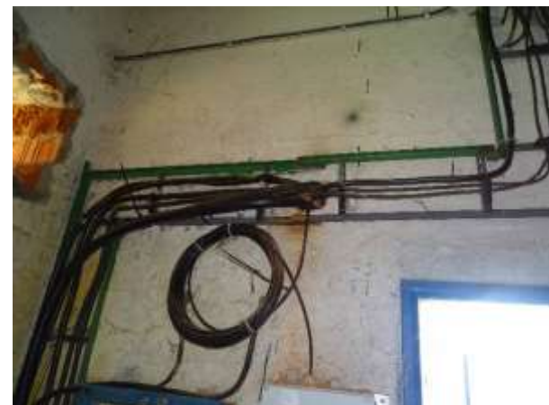
Obr. P2-12 – – stávající průraz z budovy výměníku
