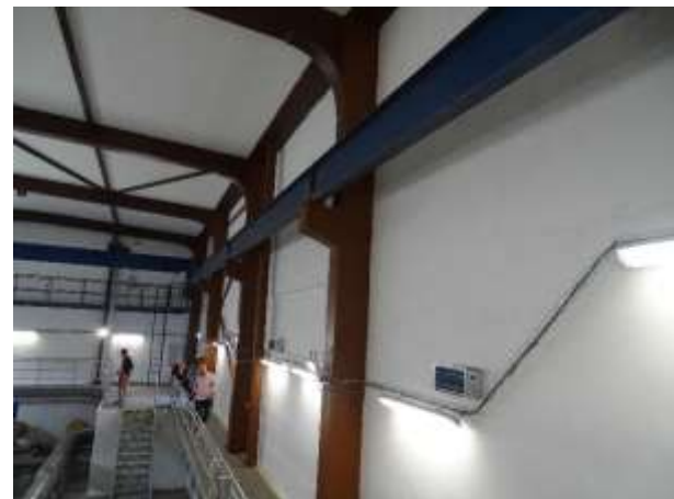
EST.11 – boční stěna kde bude ve stávajícím drátěném žlabu vedena nová kabelová trasa k novému stožáru sirény
