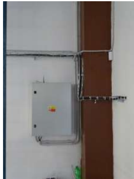
EST.11 – umístění rozvaděče sirény
