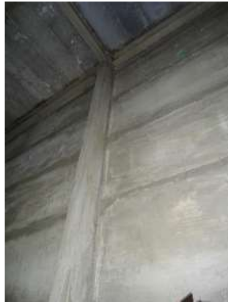
EST.11 – průraz na vnější stěnu k novému stožáru sirény, místo kotvení stožáru
