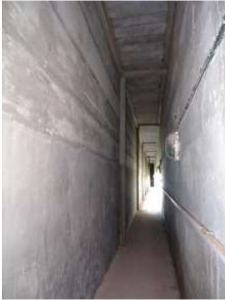
EST.11 – průraz stěnou do chodby zásobníku a nová kabelová trasa (el.trubka 40) k novému stožáru sirény a průraz na vnější stěnu
