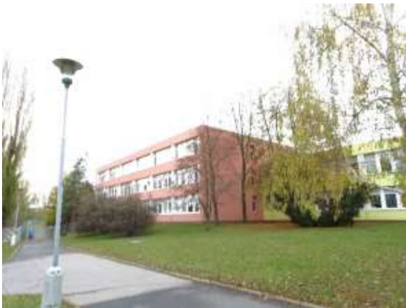
ESN.16 – stávající stožár sirény – kotvení
