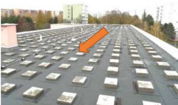
ESN.16 – místo pro nový stožár sirény kotvený do konstrukce typu trojnožka položené na betonových dlaždicích
