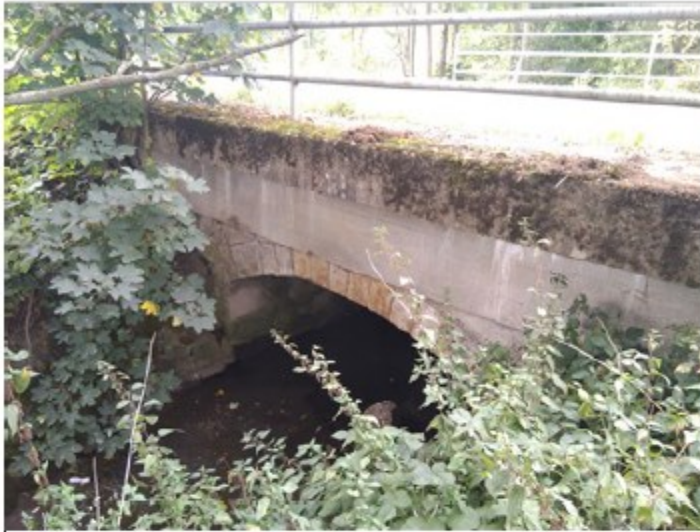
Pohled na vtokovou stranu objektu
