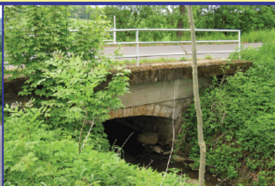
Pohled na bok mostu
