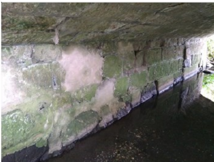
Pohled na líc levobřežní opěry a podhled NK
