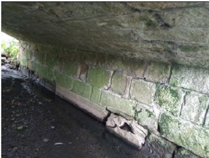
Pohled na líc pravobřežní opěry a podhled NK
