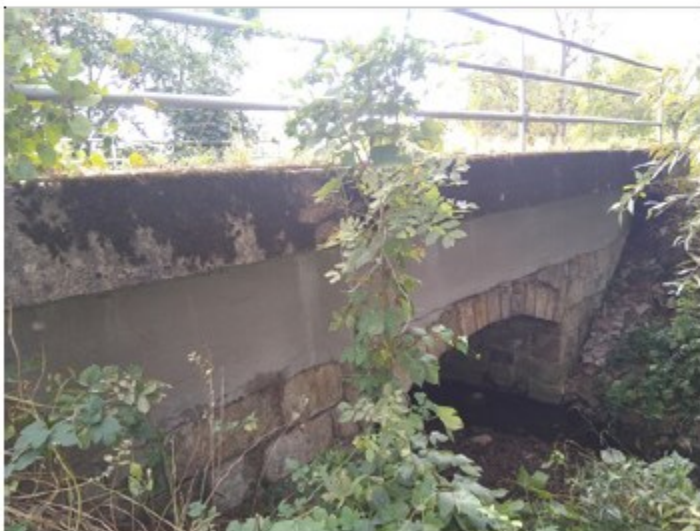
Pohled na výtokovou stranu objektu
