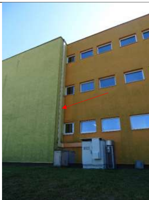
Obr. P4-2 – severní stěna budovy se stávající stoupací trasou k anténám MP
