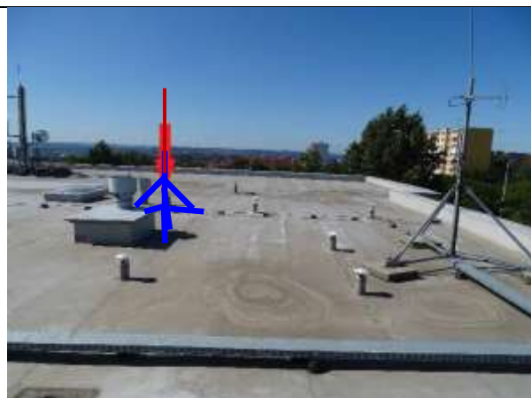
Obr. P4-10 – – konstrukce typu „trijnožka“ pro nový anténní stožár
