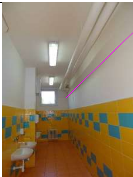
Obr. P4-4 – přívod napájení (kabel CYKY-J 3x2,5)
