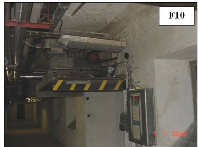
Strojovna nákladního výtahu - druhý suterén.
