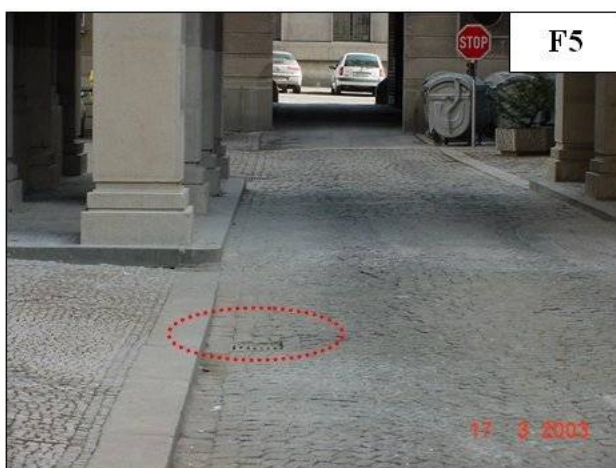
Kanalizace - vnitřní dvůr.
