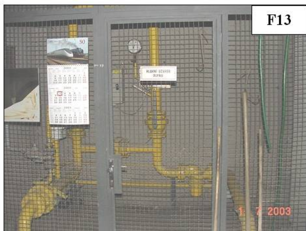
Hlavní uzávěr plynu – vozová hlavní brána, vpravo, viz Metodika
