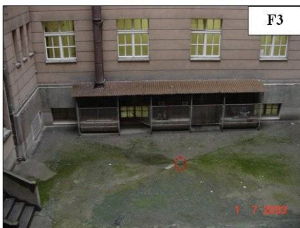
Utěsnění kanalizace - atriový dvůrek.
