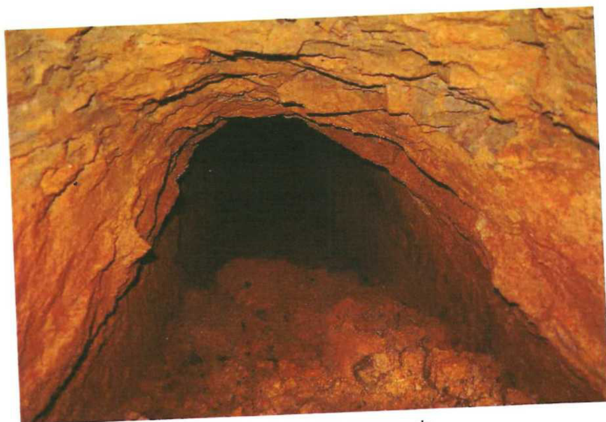
Pohled do chodby z prostoru propadu
