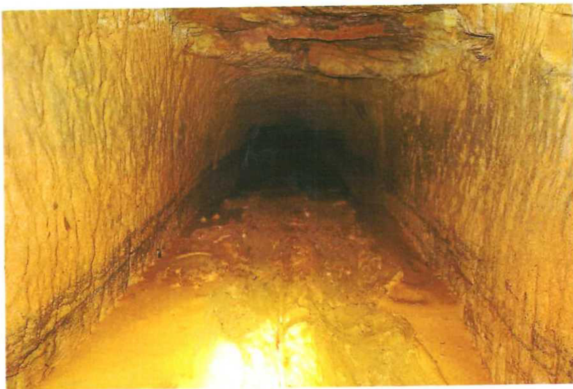
Pohled na sedimenty na počvě chody
