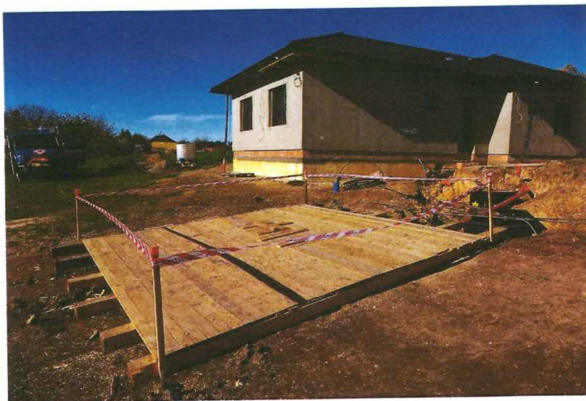
Pohled na ochranný poval s bezpečnostní zákazovou páskou
