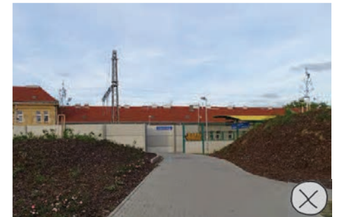
04.028 ▲ Nežřetelný přístup na nástupiště průchodem přes protihlukovou stěnu [zast. Praha-Podbaba]. #taktone #pristupnanastupiste #protihlukovastena #podbaba
