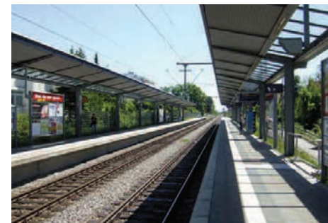
04.030 ▲ Zastřešení vnějších nástupišť [zast. München – Unterhaching, Německo]. #esko #nastupiste #zastreseninastupiste #nemecko #munchen
