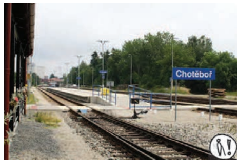
04.035 ▲ Poloostrovní nástupiště použitelné na regionálních tratích je alternativou k podchodu. V místě přecházení chybí výstražné zařízení s optickou a akustickou signalizací [zast. Chotéboř]. #nastupiste #poloostrovninastupiste #chotebor
