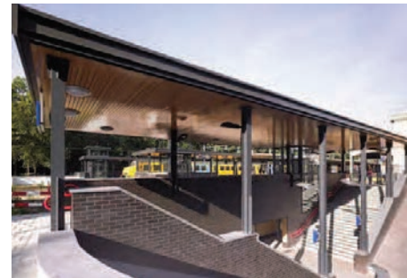
04.026 ▲ Přístup na nástupiště na pěší trase spojující území před ... #esko #pristupnanastupiste #nizozemi #baam
