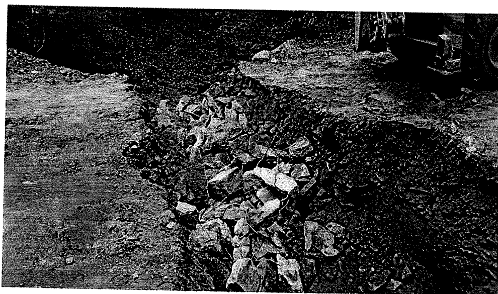
SO 101 - Pohled po zbourání propustku v km 1,492
