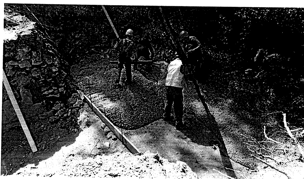
SO 104 - Betonáž podkladního betonu
