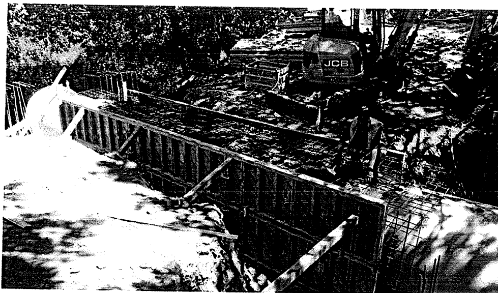
SO 104 – Obetonování ŽB rour
