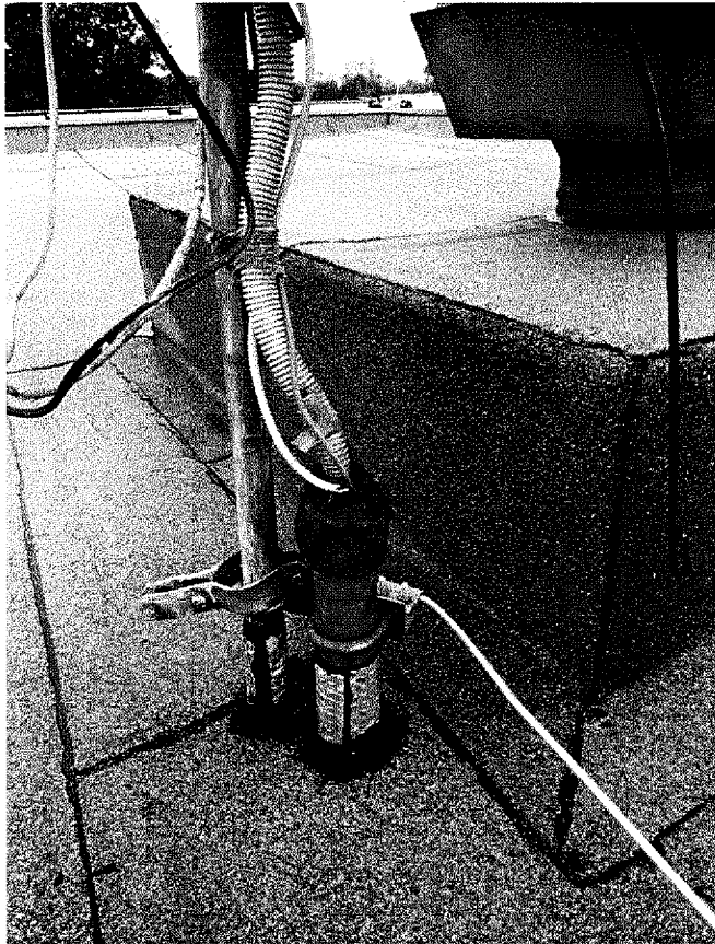
Obrázek 3 - nynější otvor ze střechy do STA rozvaděče
