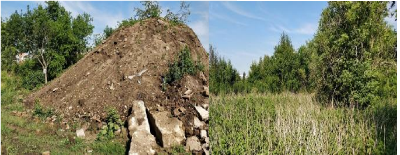
Deponie zemin po bouracích pracích k využití pro nezbytné TÚ a obnovy travních společenstev v plochách kopřiv
