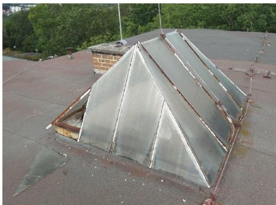
foto /3/ Pohled na světlík střechy S1
