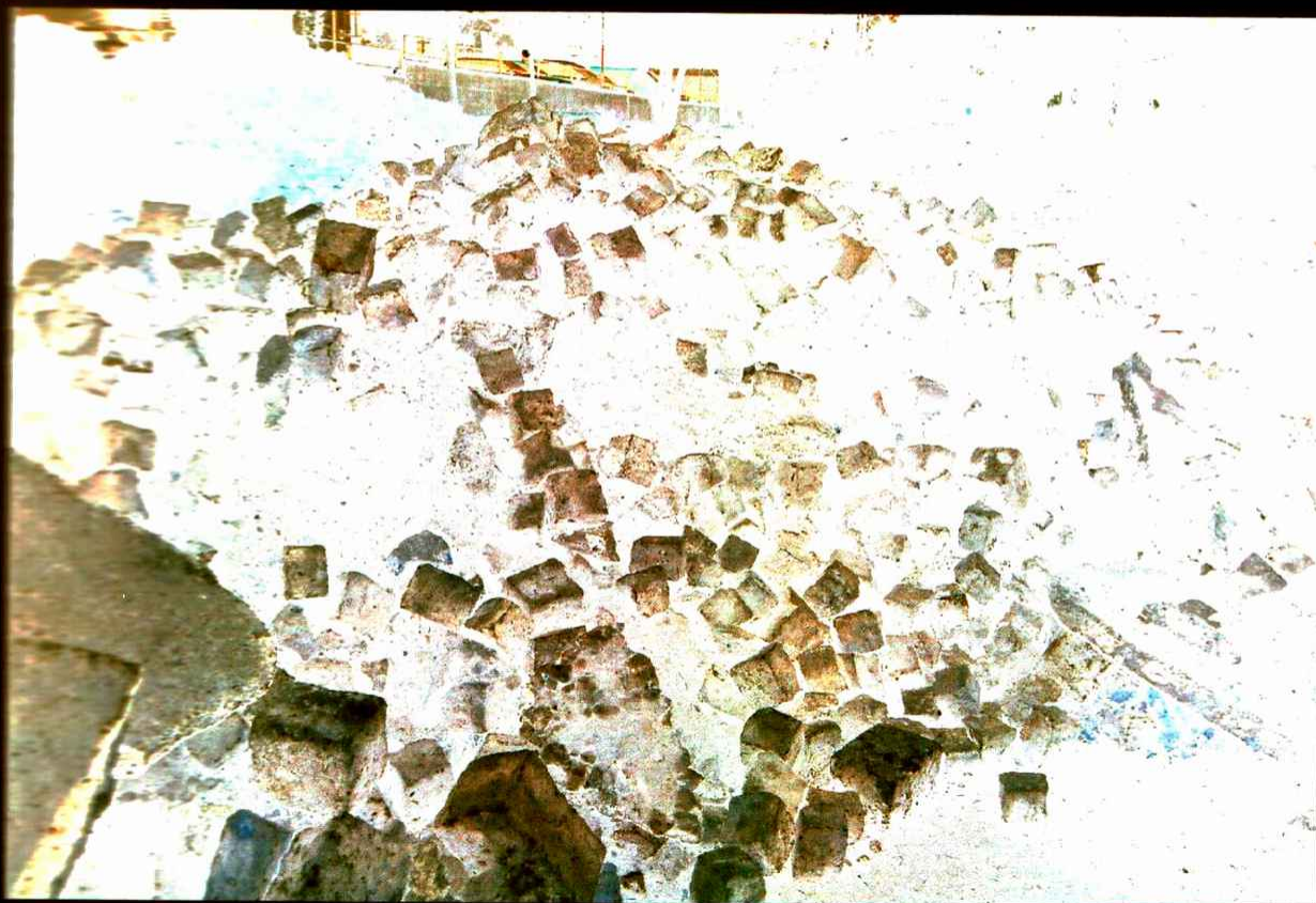
Obr. č. 2 Pohled na rozměrově atypické kostky a DK s poškozeným okrajem
