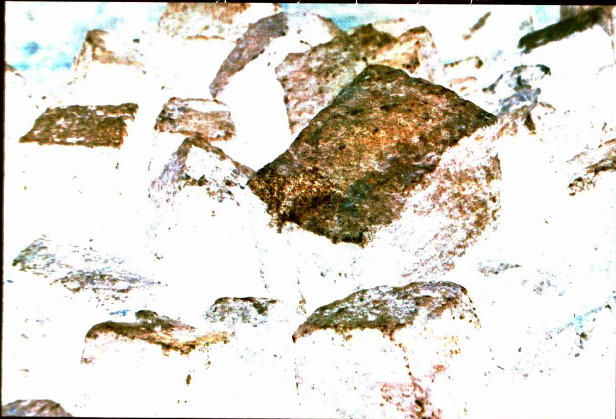
Obr. č. 2 Pohled na rozměrově atypické kostky a DK s poškozeným okrajem
