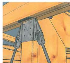
Z/07 Styčnickový plech přední, tl. plechu 8 mm, 9,37 kg
