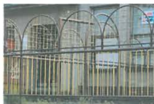
Původní ocelové tubkové zábradlí
