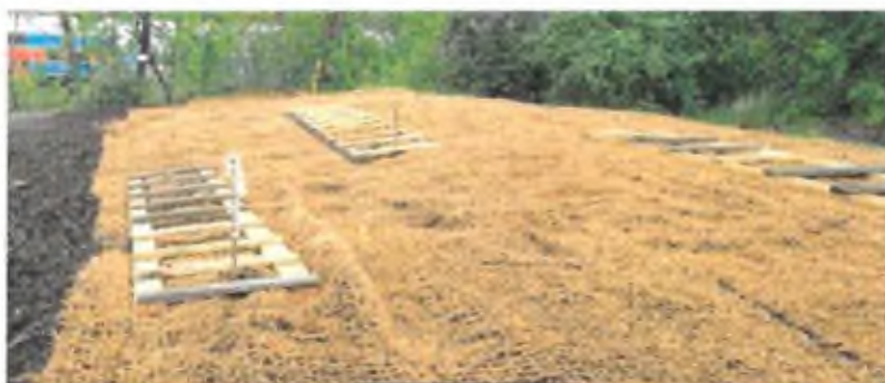
Způsob práce na svahu pomocí žebříků
