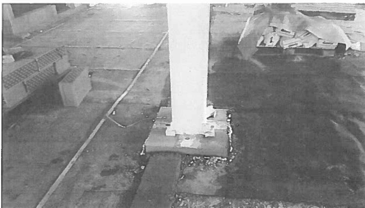
Pospojení ocelové konstrukce zemními pásky. Provedená záливka patek sloupů po odbednění.
