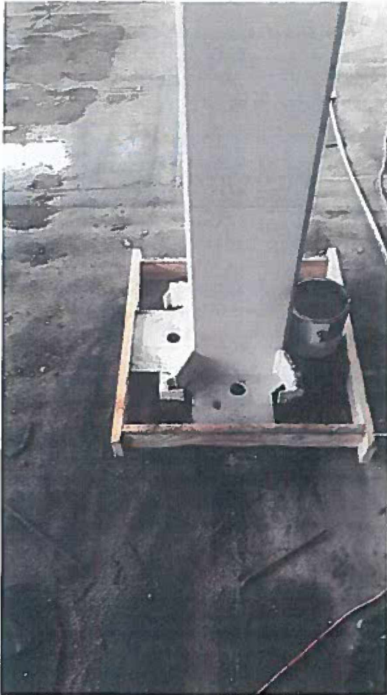
Bednění pro vysokoteplotní zálivku patek sloupů.
