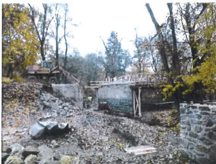
celkový pohled na staveniště v oblasti 1. pole
