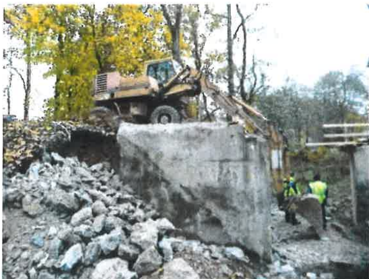
pohled na líc pravého křídla opěry 1
