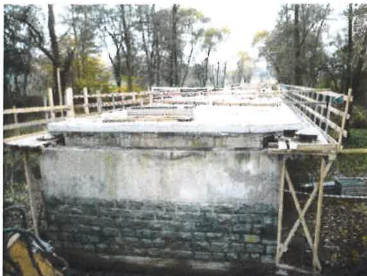
pohled na čelo NK nad pilířem 2.
