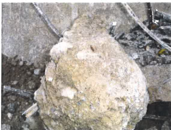
detail kusu vybouraného betonu desky mostovky 1. pole
