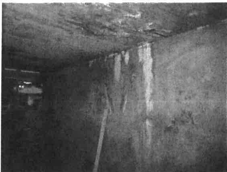
pohled na líc opěry 1
