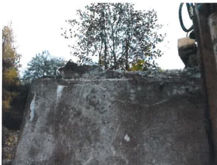
pohled na líc dřívku opěry 1
