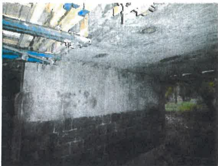
pohled na líc pilíře P2
