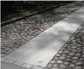
204 Vhodné doplnění pohodlné hladké velkoformátové dlažby do povrchu historické dlažby, která není pro chůzi pohodlná [ Švédsko, Stockholm ]
