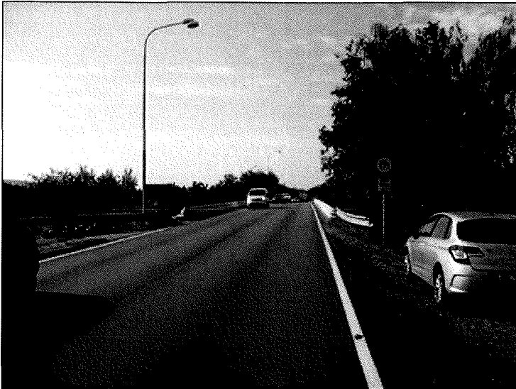
pohled na most ve směru staničení
