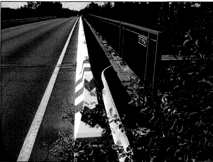
pravá část mostu, nové zábradlí, nová vodící stěna na obrubníku, tabulka s evidenčním číslem na zábradlí
