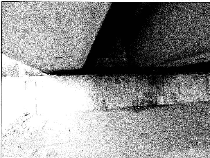
stopy po průsacích na líci O1
