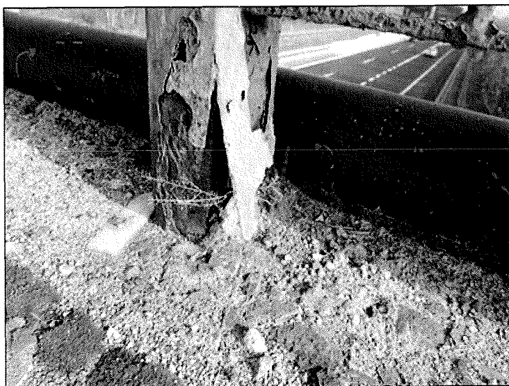
koroze zábradlí
