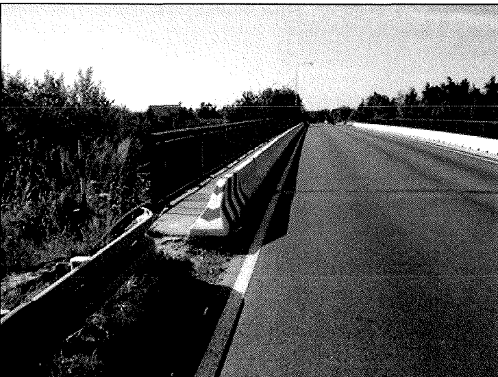
levá část mostu, nové zábradlí, nová vodící stěna na obrubníku mostu
