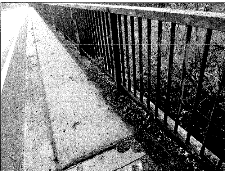
koroze zábradlí
