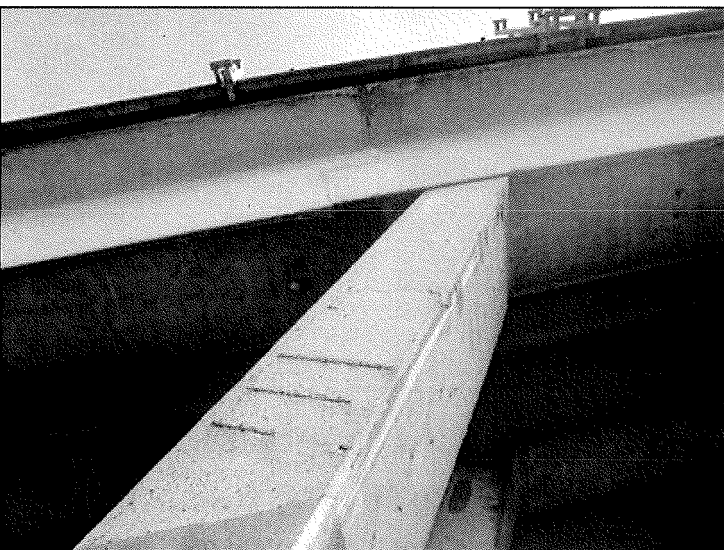
podhled 4. nosníku u P2
