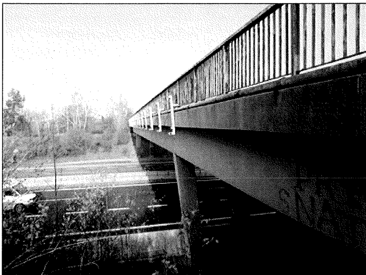
pravý bok mostu
