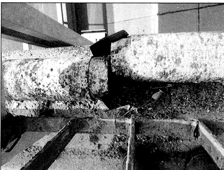
detail styku chrániček na pravé římse
