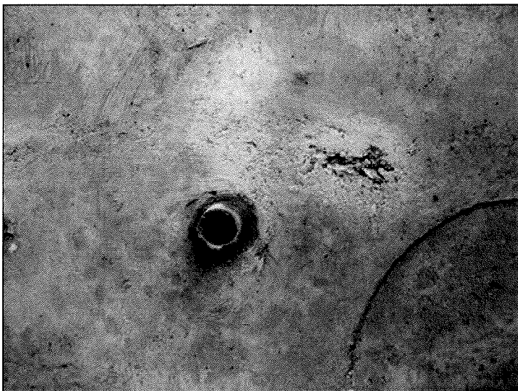
detail odvodnění dutiny nosníku
