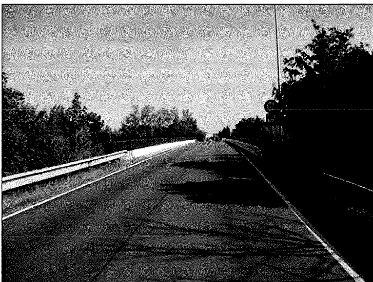
pohled na most proti směru staničení
