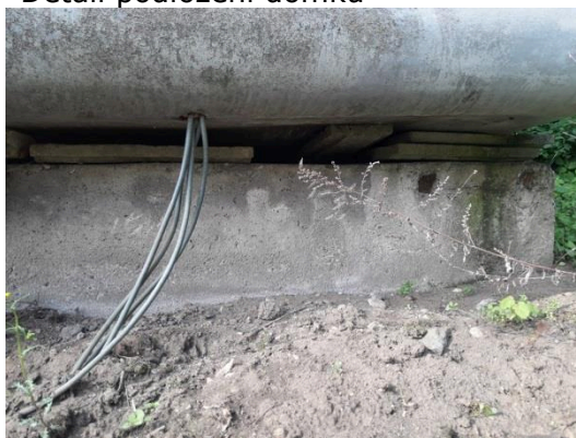
Detail podložení domku
