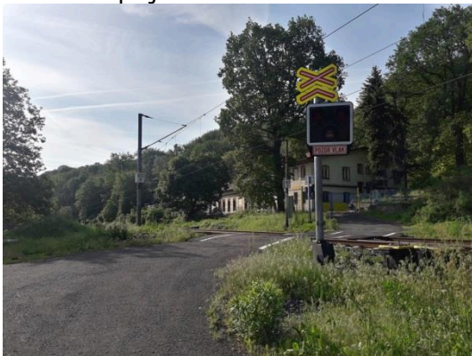
PZS směr příjezd od hlavní komunikace
