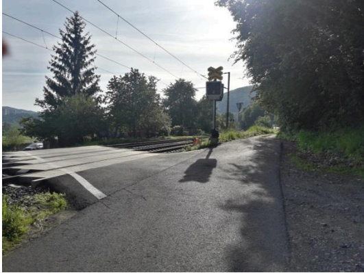
PZS směr od ul. K Loděnici
