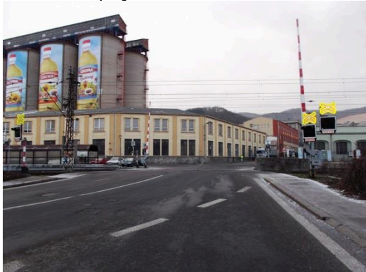
PZS směr příjezd od hlavní komunikace
