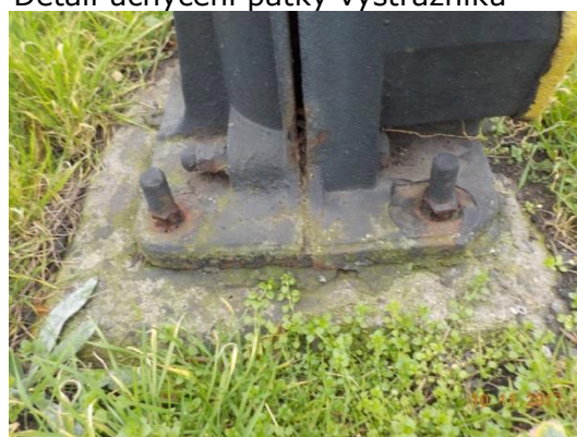
Detail uchycení patky výstražníku
