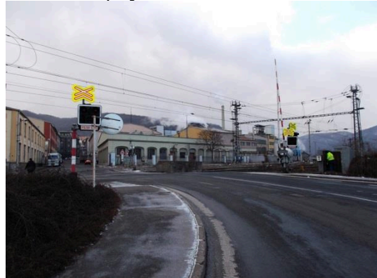
PZS směr příjezd od hlavní komunikace
