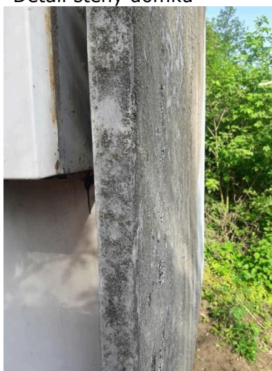
Detail stěny domku
