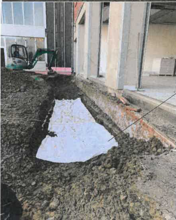
Sanace č.3 před vjezdovými vraty
