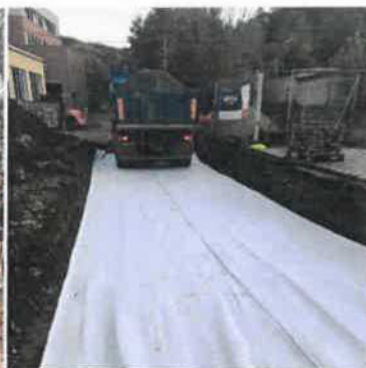
Sanace pod příjezdovou komunikací (sanace č.6)
