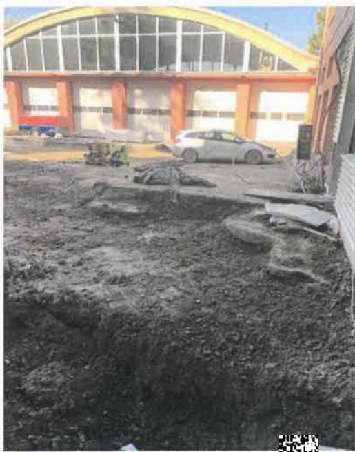
Betony pod vozovkou
