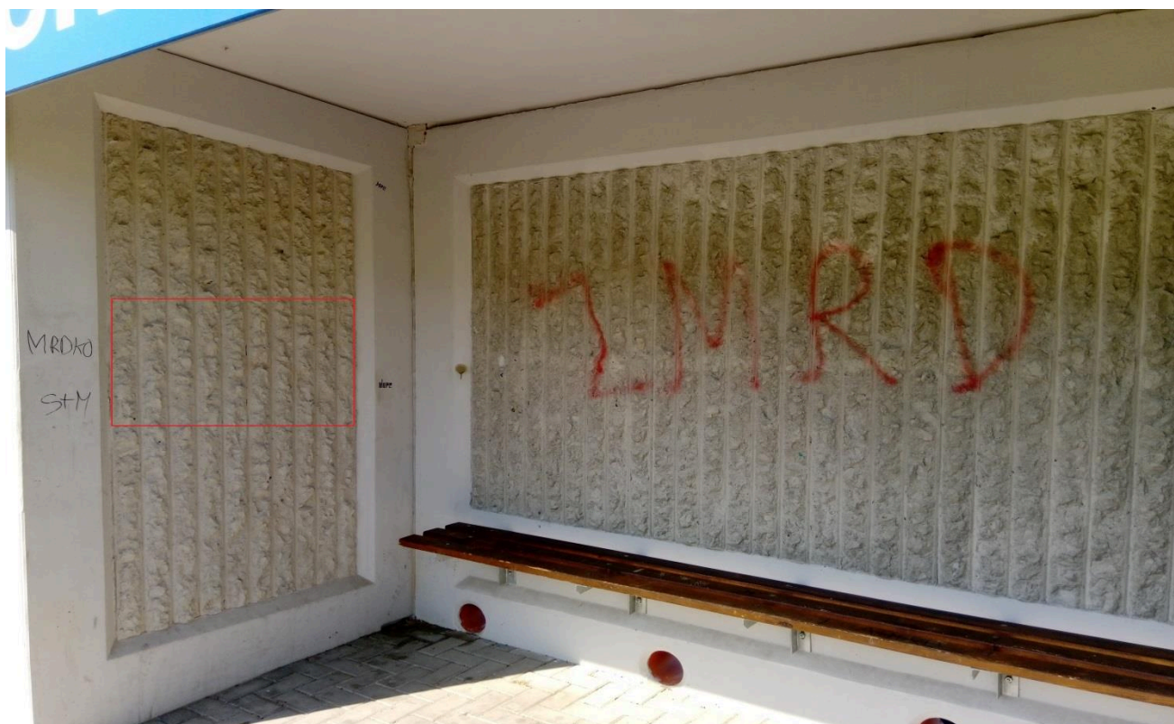
Zastávka Červená Voda, Pod Rozhlednou (přístřešek)
