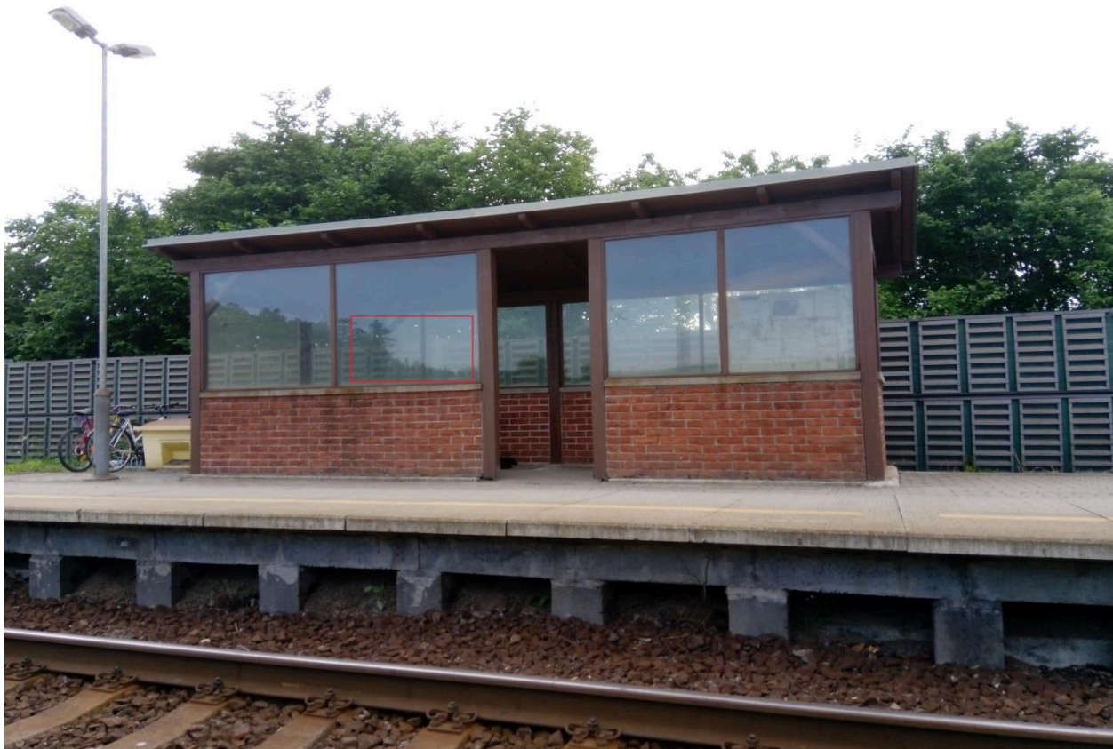
Zastávka Verměřovice (přístřešek)
