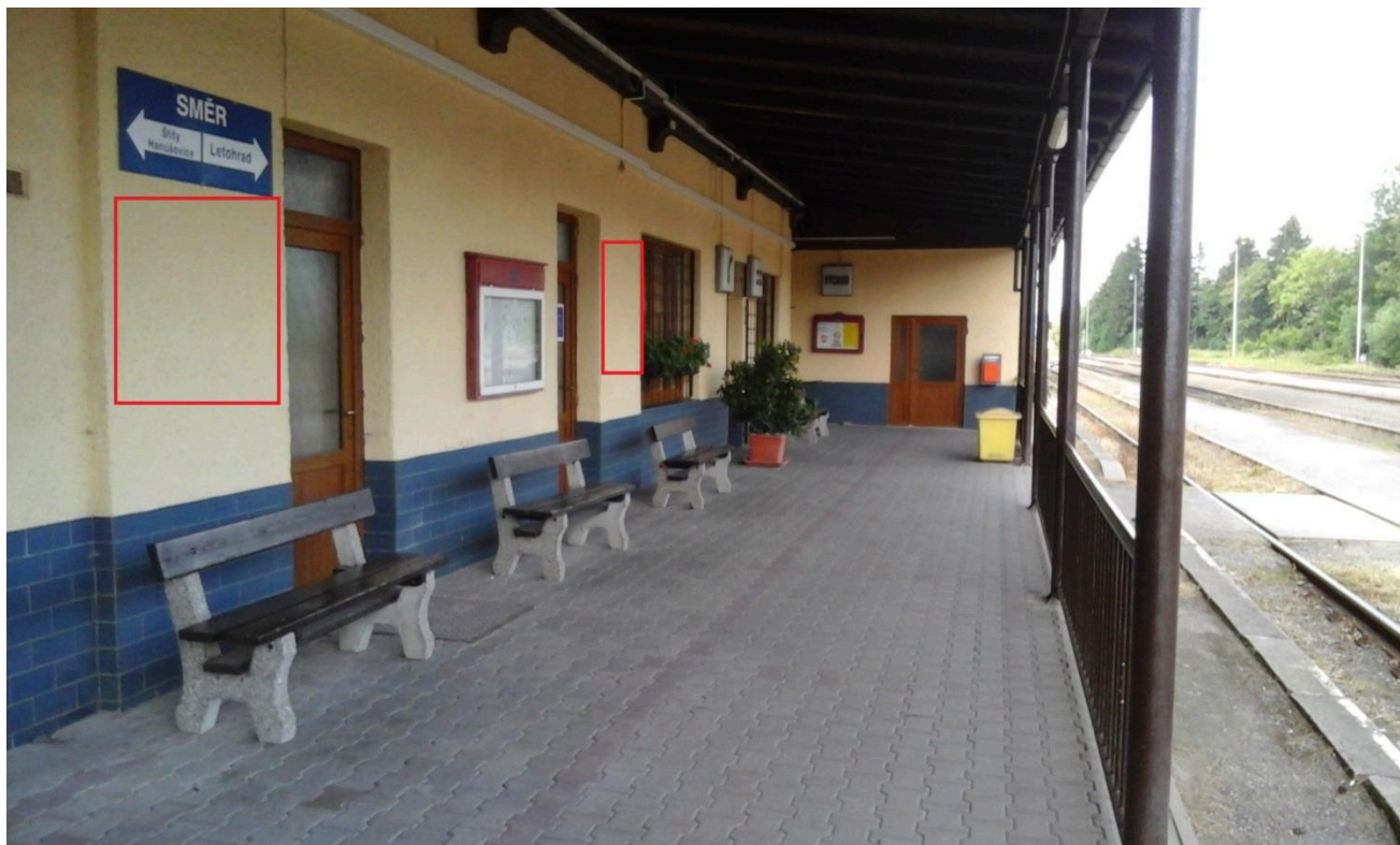
Výpravní budova žst. Dolní Lipka (nástupní prostory)
