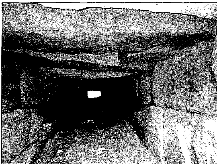
Podhled konstrukce zprava
