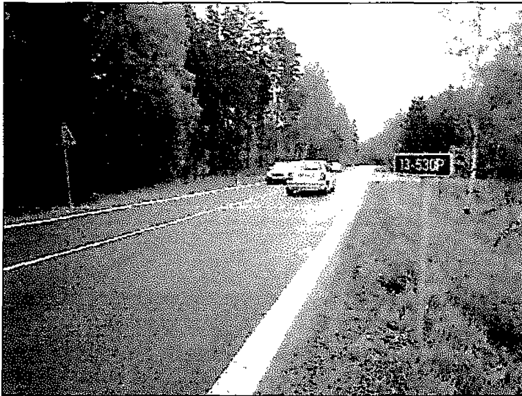
Pohled po směru staničení
