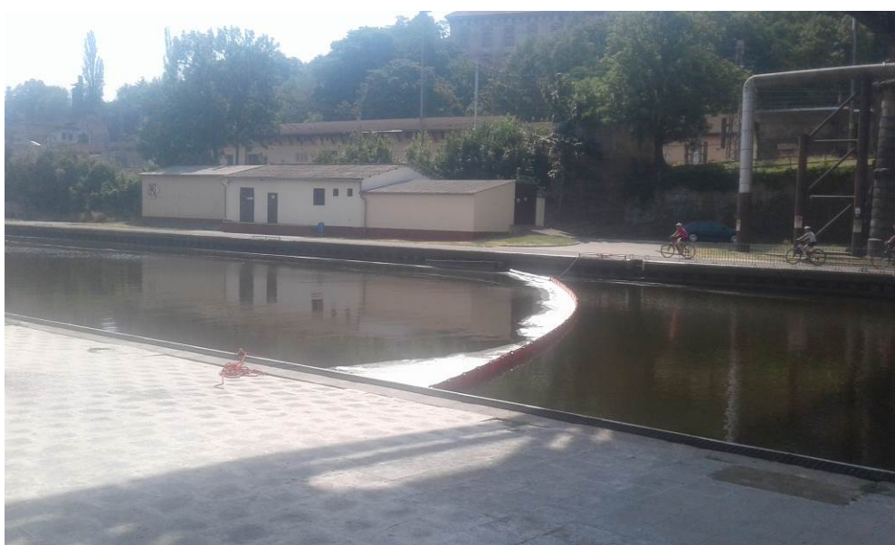
Instalovaná normá stěna HZS v horním plavebním kanále
