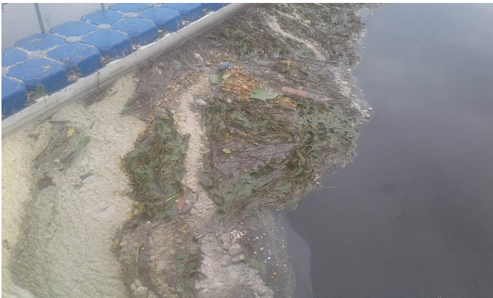
Havarijní zanečištění, zachycené na normé stěně
