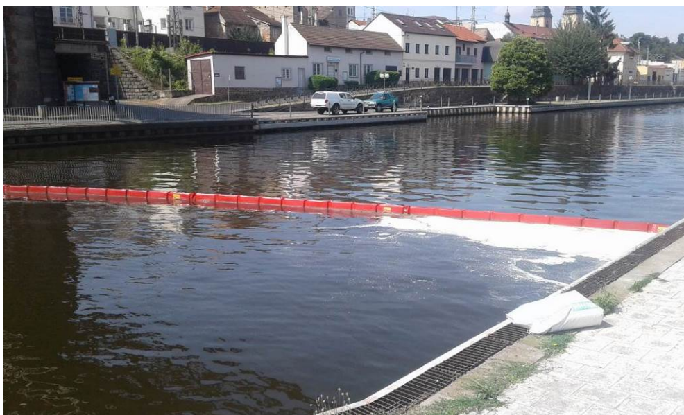
Normá stěna v HPK se sorbentem
