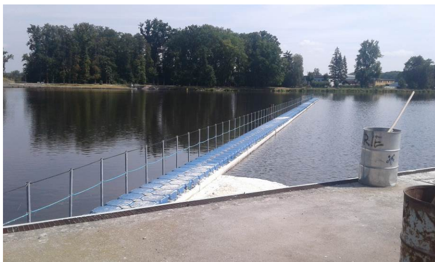
Instalovaná normá stěna v havarijním profilu Roudnice n.L. – v profilu jezu
