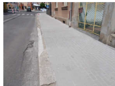
Fotka po dokončení.
