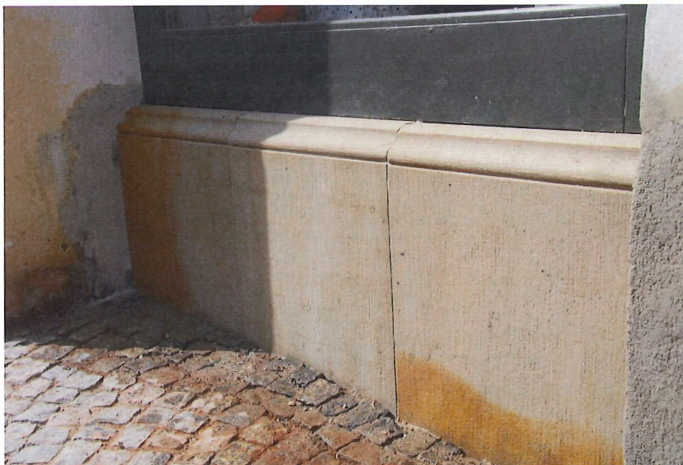
Příklad podobně realizovaného nového masivního soklu s profilací.
