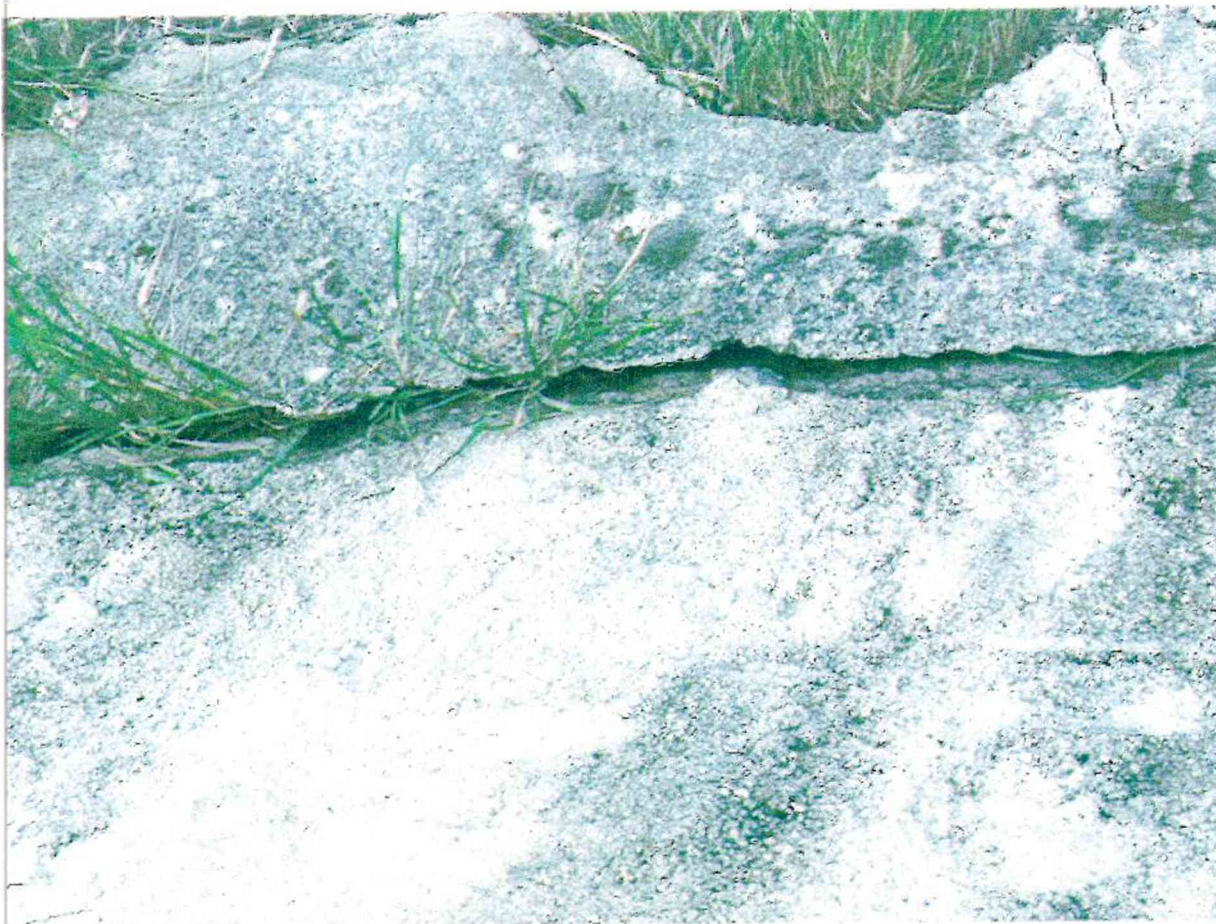
Obrázek 4: Praskliny na stávající opěrné stěně, která je umístěná v těsné blízkosti nemovitosti č.p. 86, 128
