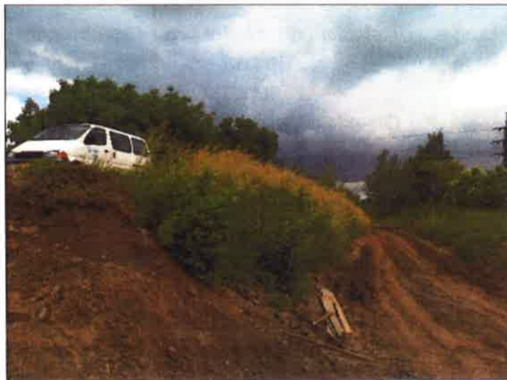
2 - násypové těleso komunikace
