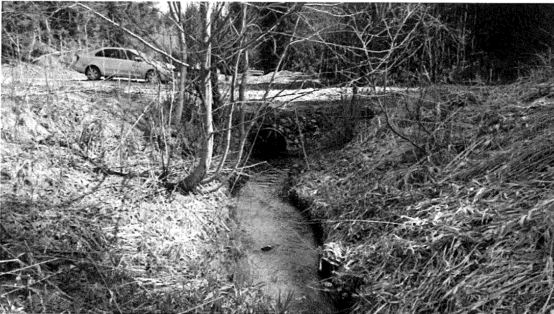
Propustek na lesní cestě
