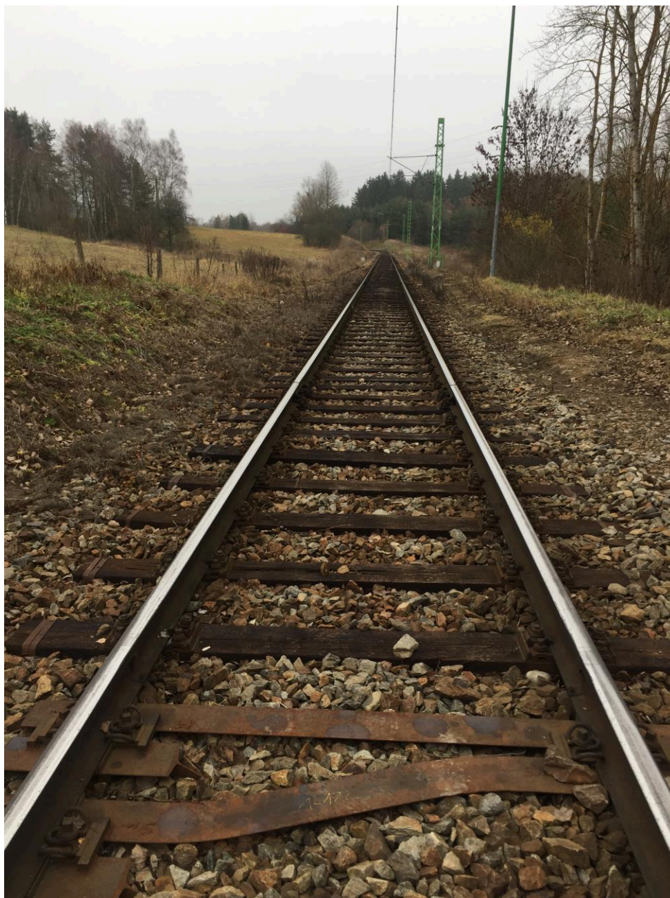
Foto č. 1: kolej v km 2,239 – starý stav
