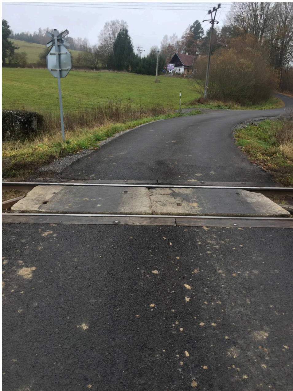
Foto č. 2: přejezd P6110 – starý stav
