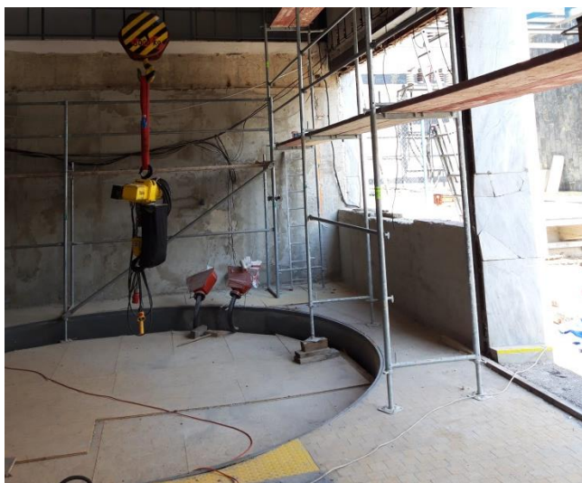
Obr. č.6 – Zaklopení otvoru po demontáži turbíny KT 2400
