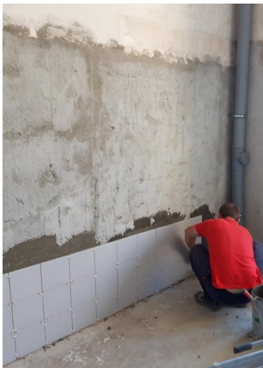
Obr. č.8 – Vyrovnaný podklad před montáží obkladu
