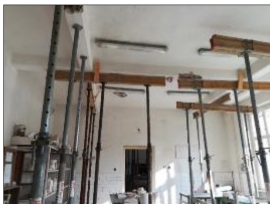
Podstojkování železobetonových stropů
