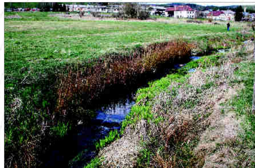
Obr. 150b. Obrostlý haťošterkový válec po první vegetační sezóně ve Zbytinách (podrobněji viz Příloha 23).
