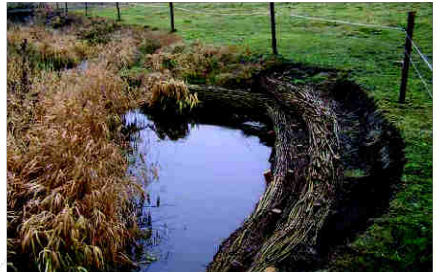
Obr. 198a. Realizace většího množství oživených hafošterkových válců podle projektu Vejmělkové a Simona (2006) realizoval v listopadu 2006 správce toku ZVHS Prachatice (dnes podnik Povodí Vltavy).
