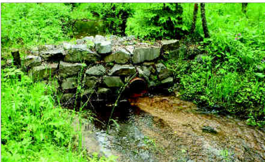
Obr. 144. Polopropustná přehrážka. Tato přehrážka je za normálního vodního stavu průtočná, v případě zvýšení průtoku ale protéká jen část určená kapacitou trubky. Nadbytečný průtok se vzvedne a vyběží určeným směrem. Trubka musí být stále zavodněna a bez proudového skoku, aby netvořila migrační překážku pro pstruhy.
