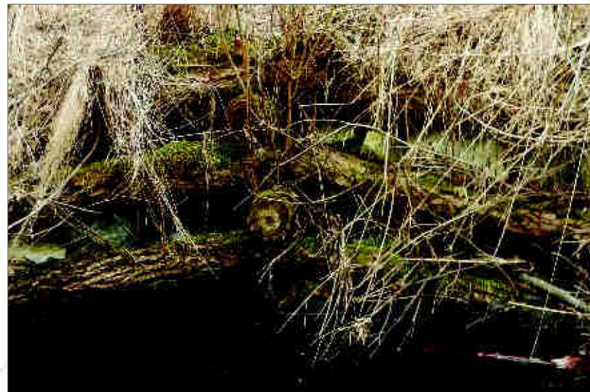
Obr. 154a. Živé srubové konstrukce z vrb. Detailní pohled na oživenou srubovou konstrukci z vrbovým járem – vrbové kmeny proložené lomovým kamenem.
