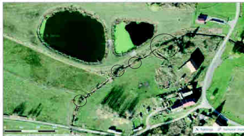
Obr. 201. Pohled na současný stav obrostlých válců (velký snímek, haťošterkové válce v černých kroužcích) a stav napřímeného koryta před revitalizací (na vloženém snímku z roku 2004). Zdroj: Mapy.cz, © Seznam.cz, a.s., © TopGis, s.r.o.).
