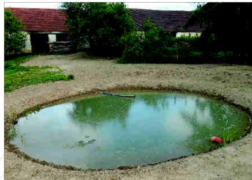
Obr. 83a. Malý dočišťovací rybník u zemědělské usedlosti v obci Malovice u Vodňan za domovní ČOV pro pět ekvivalentních obyvatel krátce po svém založení (prostá zemní nádrž v jílovité zemině). První nádrž ze série dvou nízko zatěžovaných biologických nádrží.
