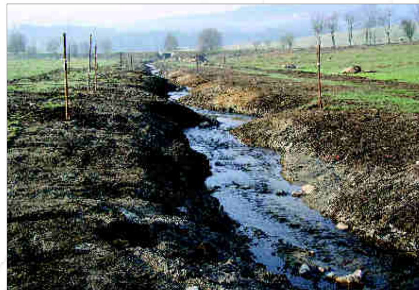
Obr. 151a. Průběh revitalizace na Zbytinském potoce. Vytrhání celoplošných panelů a ponechání nepřirozeně zahloubeného koryta na Zbytinském potoce na podzim 2004 vedlo k nadměrnému vnosu splavenin do hlavního perlorodkového toku Blanice.
