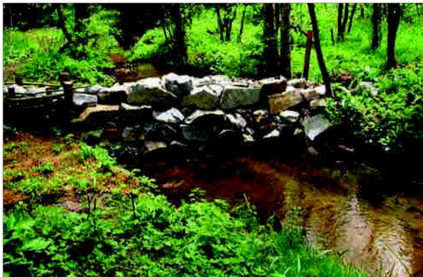
Obr. 147a. Technická realizace opatření na Lučním potoce v povodí Zlatého potoka. Rozliv těsně po dokončení stavby (zřetelná je plastová trubka převádějící celý běžný průtok a využití kokosových rohoží).
