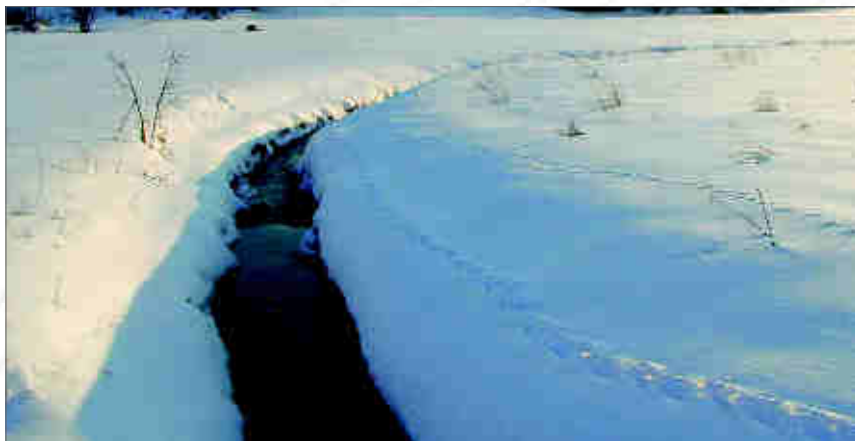
Obr. 194a. Stav koryta Zbytinského potoka v roce 2003 – napřimené rovné koryto zahloubené cca 1 m pod terén, celoplošně opevněné betonovými deskami.
