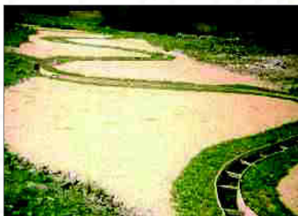
Obr. 138b. LORP – NPP Lužní potok – kolem dosud suchého koryta je vidět postupně prokořeňující drn. Zbývá plocha obou ORP pak bude překryta překompostovanou zeminou obohacenou o vápník v organické podobě (blíže k možným chybám při konstrukci viz Příloha 4).
