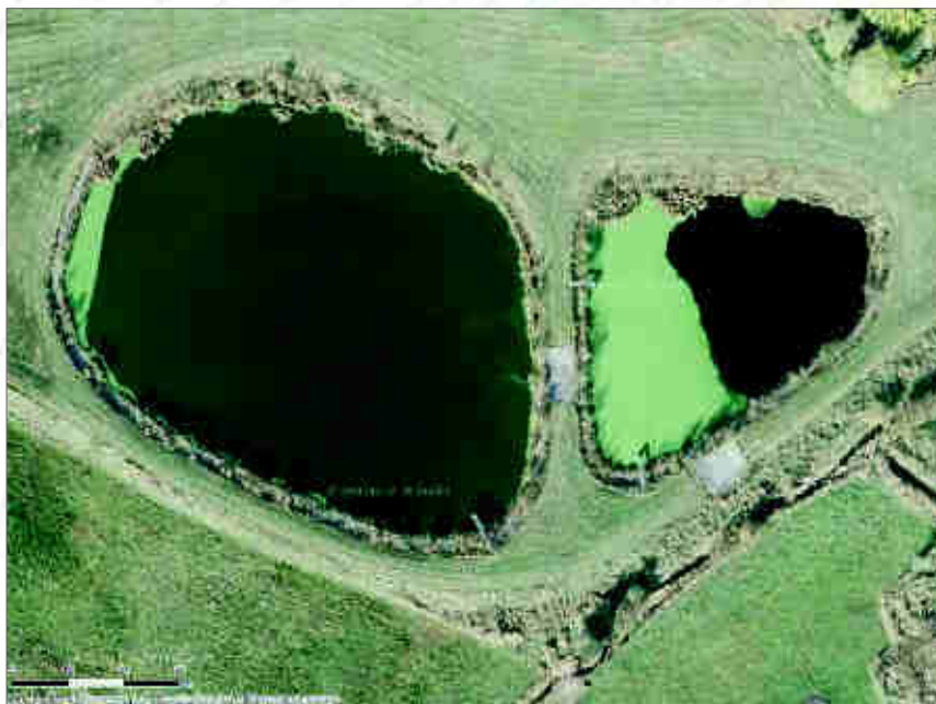
Obr. 82. Letecký pohled na nízkozatěžované biologické dočišťovací rybníky v obci Zbytiny. (Zdroj: Mapy.cz, © Seznam.cz, a.s., © TopGis, s.r.o.).
