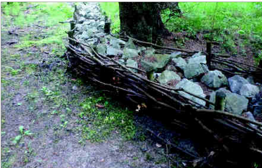
Obr. 143. Hrázka tvořená dvojitým vrbovým oplůtkem a vyplněná uvnitř lomovým kamenem. Při vyšších vodních stavech voda částečně hrázku obtéká, částečně protéká skrz. Jemnozrné i hrubozrné splaveniny se zachytávají před hrázkou.
