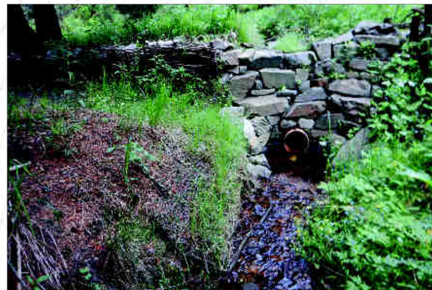
Obr. 147d. Podobné místo jako (a) po průchodu několika povodní (po kterých následovalo vyčištění okolí trubky) a zapojení vegetace.
