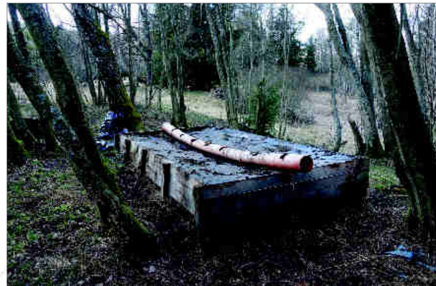
Obr. 127. Zakládání kompostu na Blanici – odchovna stanice Spálenec. Plastová trubka s vyřezanými otvory slouží k provzdušnění kompostované hmoty a odvodu výluhů. Je zabudována do středu kompostované hmoty na vrchu zakládky.
