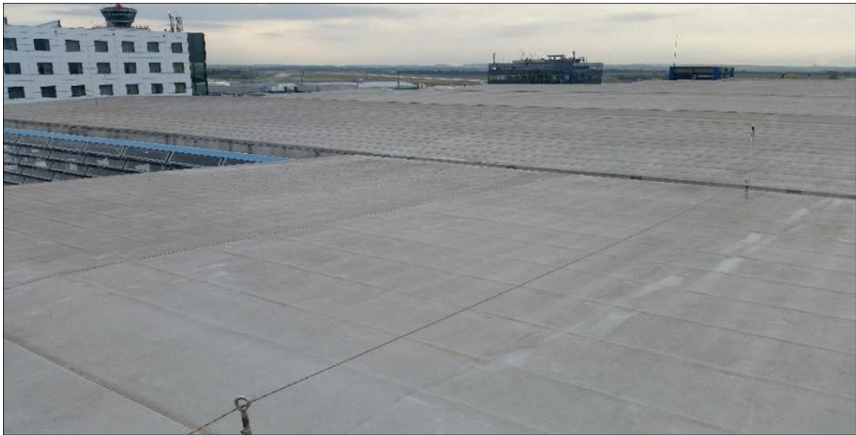
Obr. 8 - Lanový záchytný systém parkingu C
