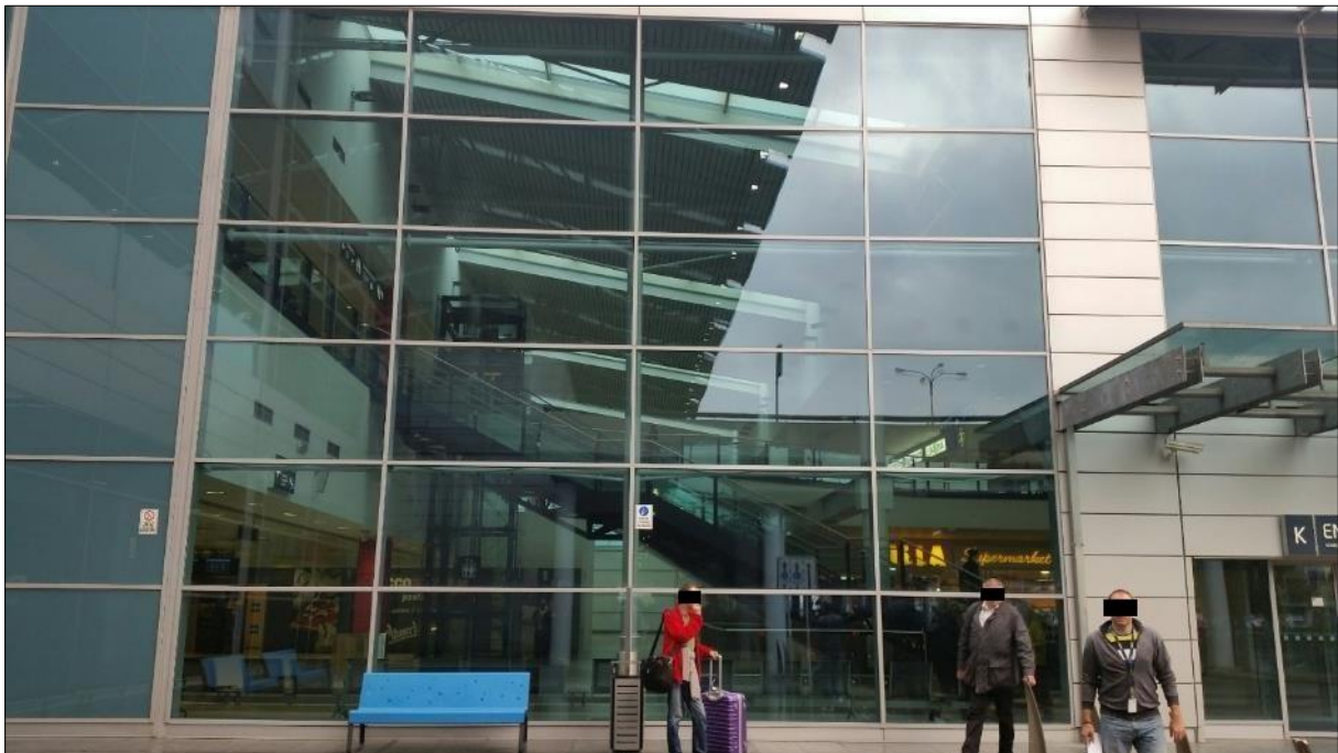
Obr. 11 - Skleněná fasáda zavěšená – SO
