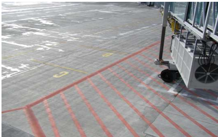
Červená „zebra“ operačního prostoru nástupního mostu. Platí zde absolutní zákaz odstavování MMP a odkládání sebemenších předmětů
